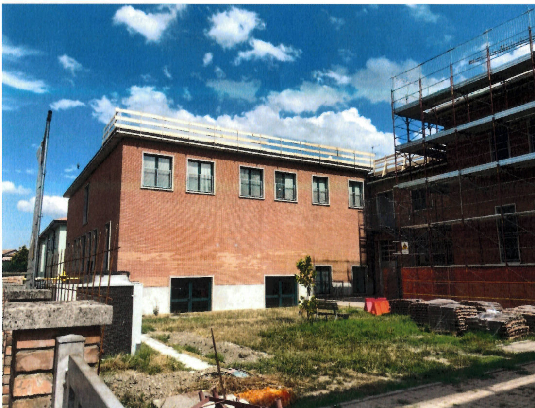
Montaggio barriere anti caduta
