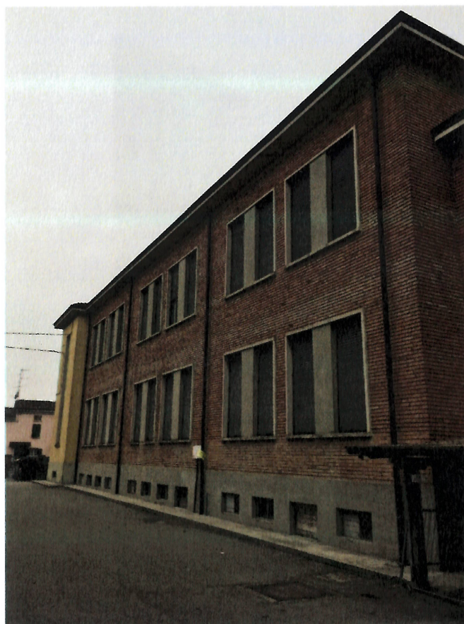
Fronte Sud – il corpo storico con le aule
