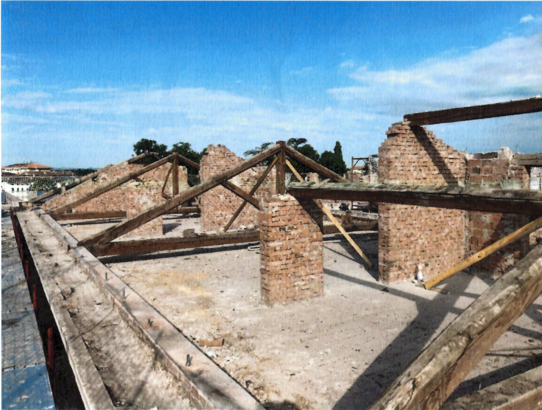
Realizzazione cordolo perimetrale e rimozione orditura primaria
