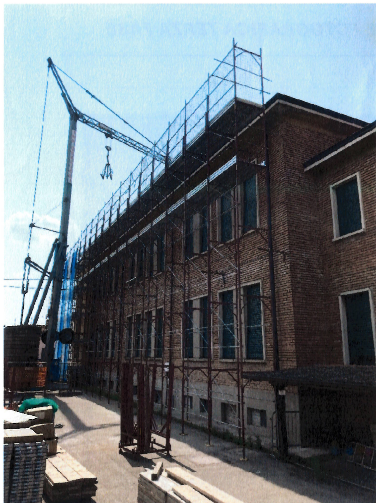
Montaggio ponteggio
