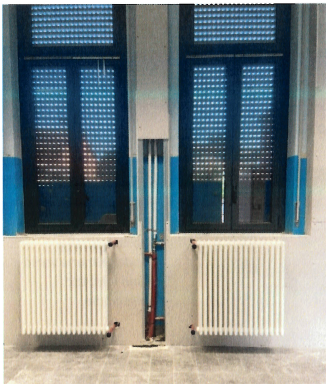
4. Posa di nuovi corpi radianti.
