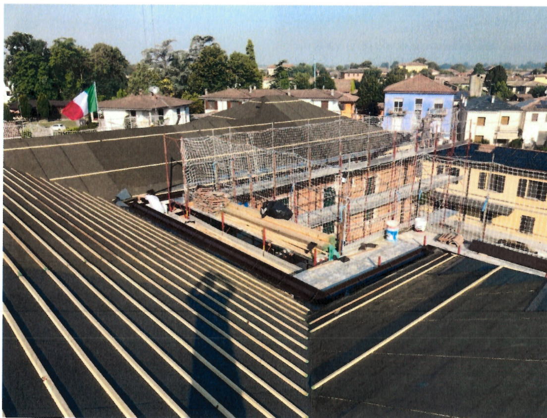
Posa guaina bituminosa
