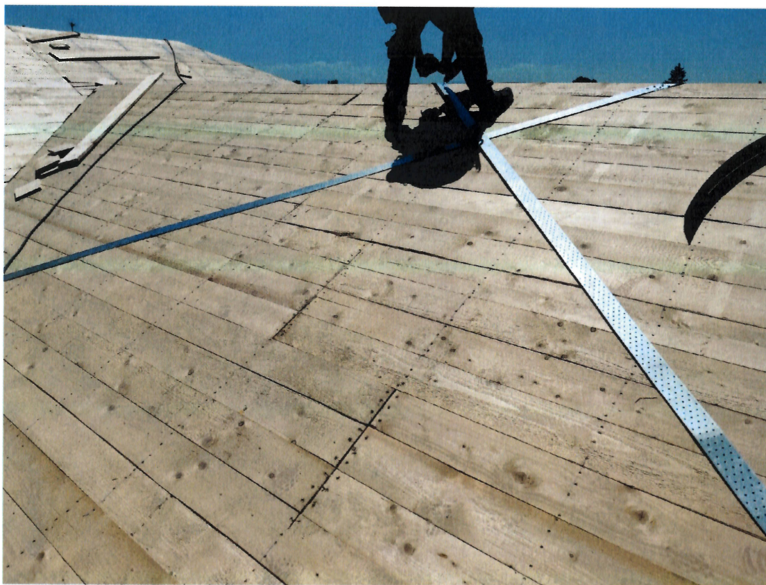
Posa controventi in acciaio
