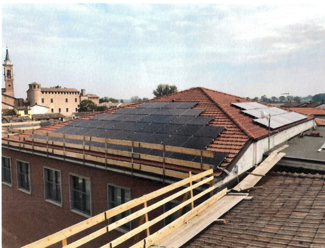
Posa nuovo impianto fotovoltaico
