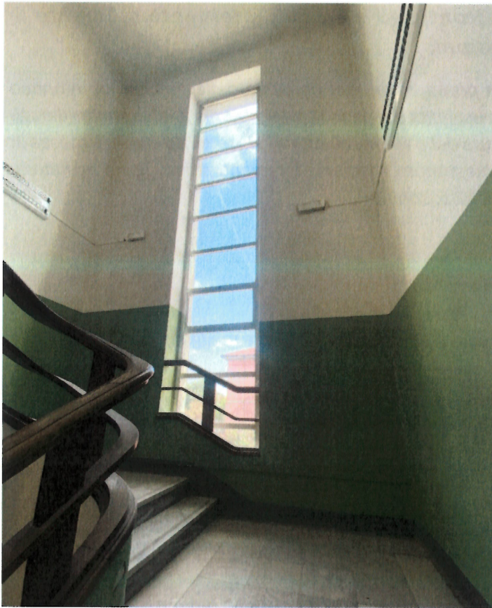
Sostituzione del serramento del vano scala
