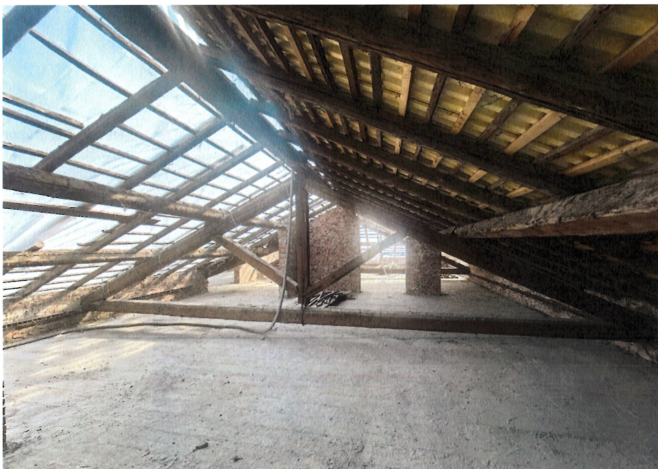
Rimozione orditura secondaria
