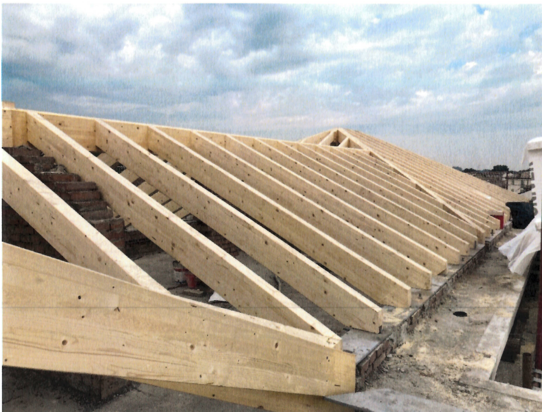
Montaggio nuova struttura di copertura
