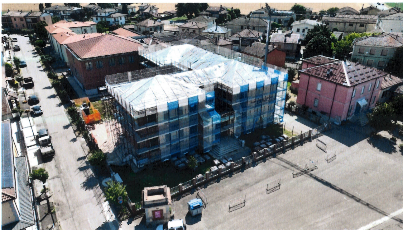
Rimozione tegole e messa in sicurezza mediante teli impermeabili
