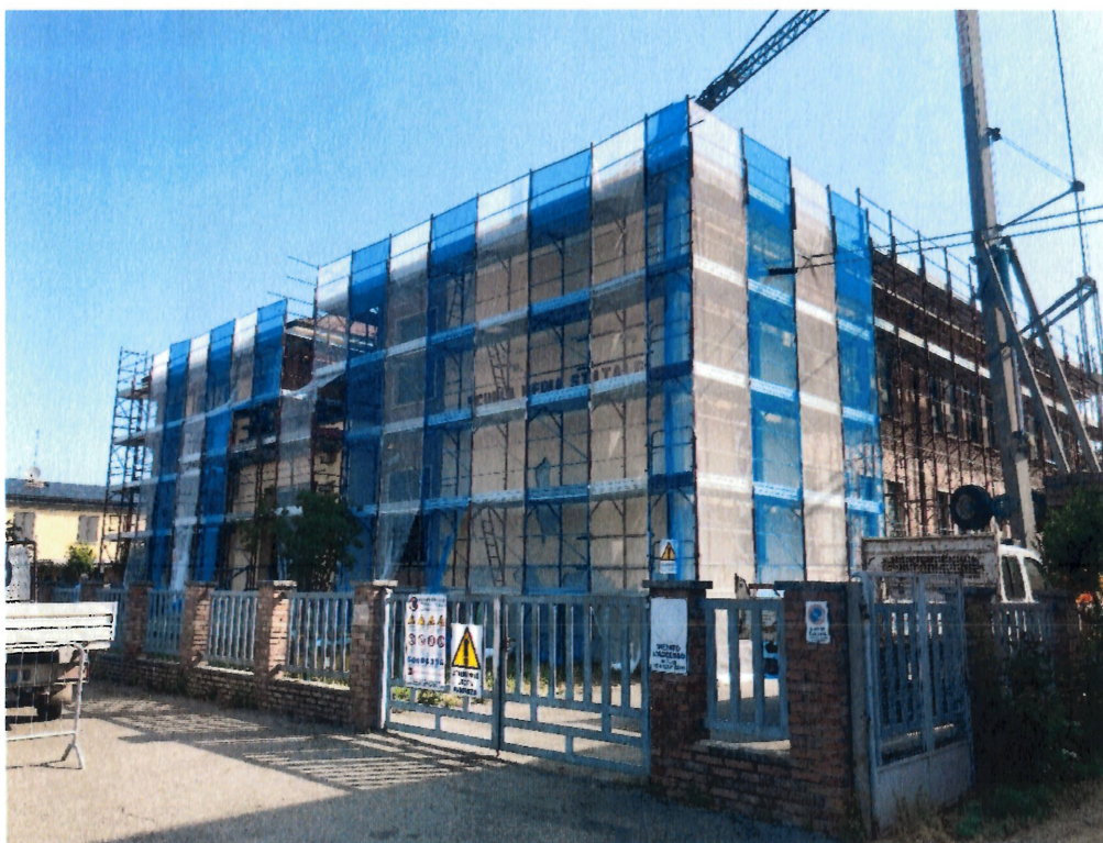
Montaggio ponteggio
