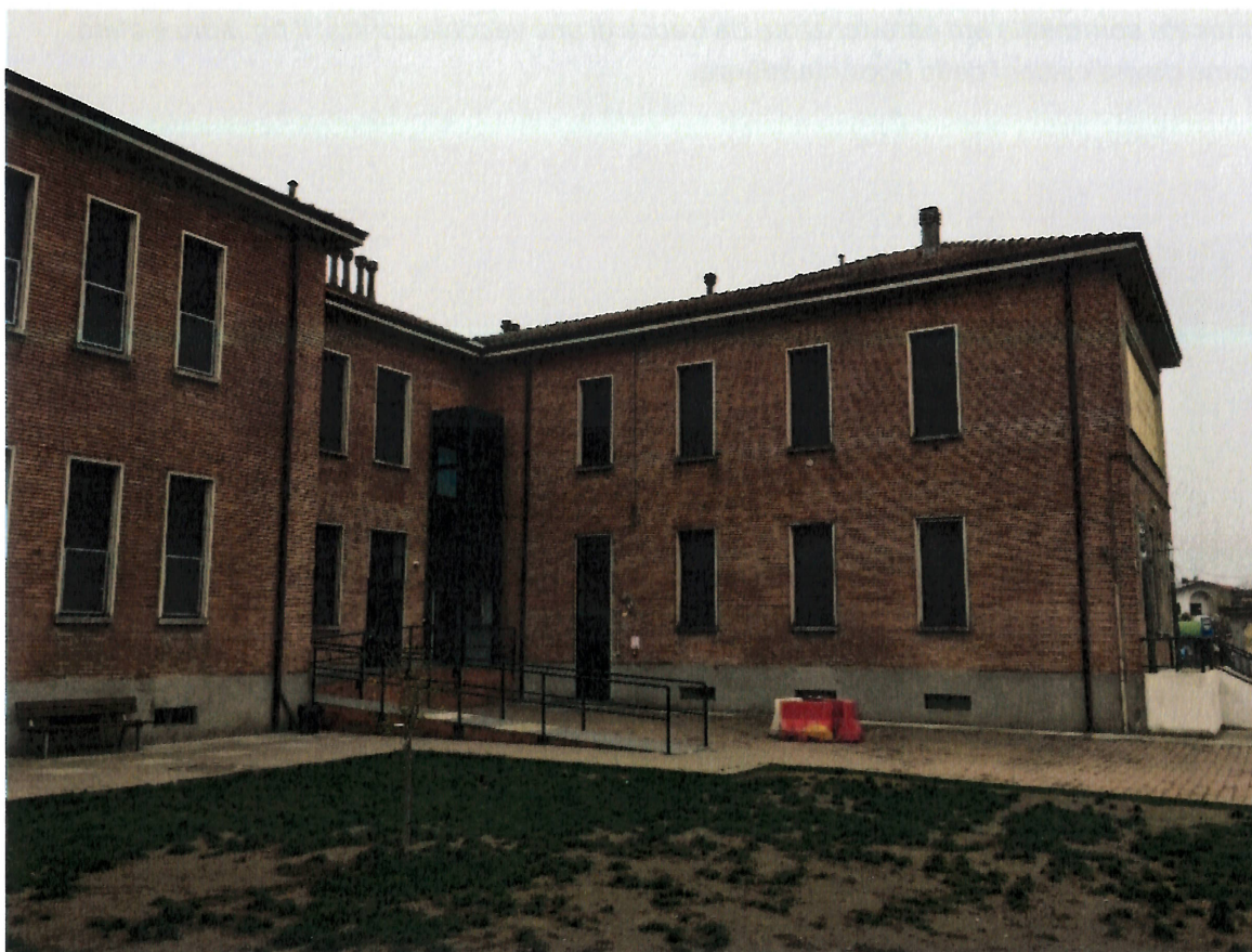
Fronte Nord – vista interna del cortile del fabbricato
