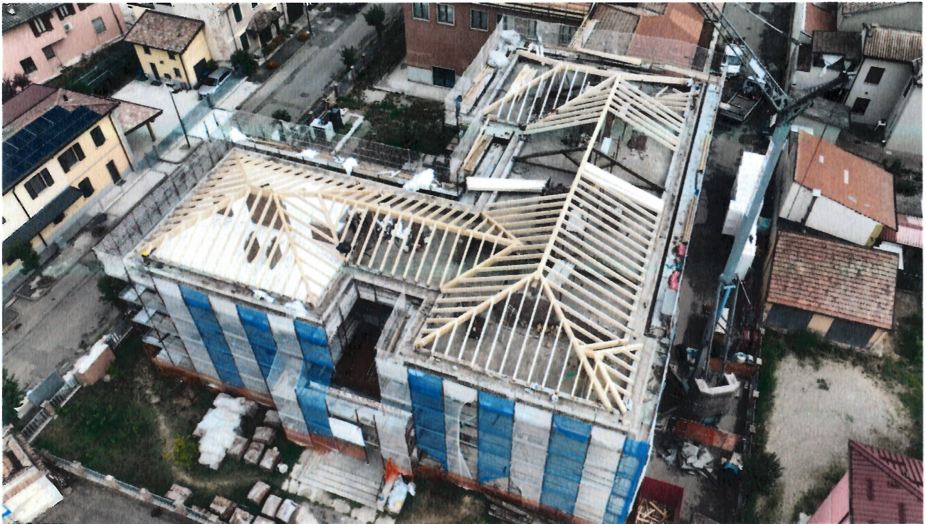
Montaggio nuova struttura di copertura e posa isolante a pavimento
