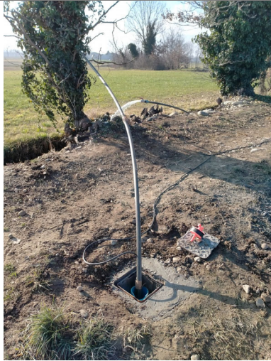
Pozzetto con chiusino in elevazione + protezione in cls
