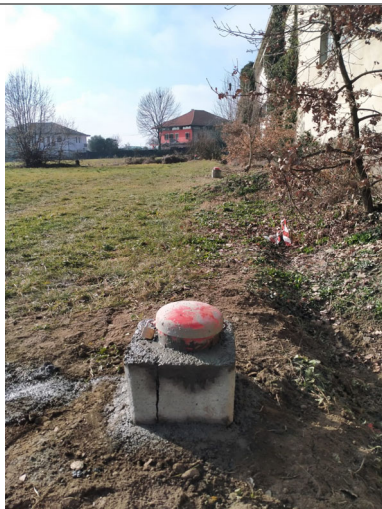
Pozzetto con chiusino in elevazione + protezione in cls
