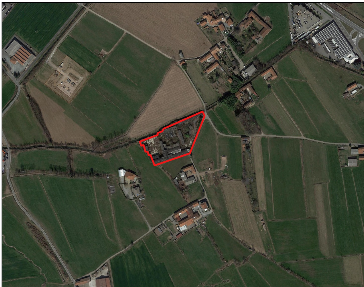
Figura 1: Vista aerea dell'area "ex Metalchimica" (fonte Google Earth). Scala circa 1: 5.000.
