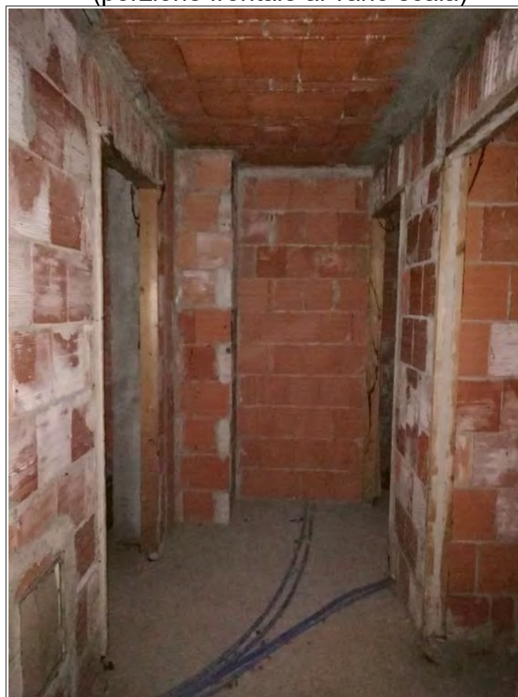
Foto 2: Particolare 2 del disbrigo (porzione frontale al vano scala)
