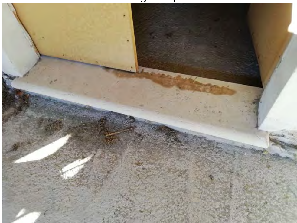
Foto 15: Particolare delle soglie in pietra naturale
