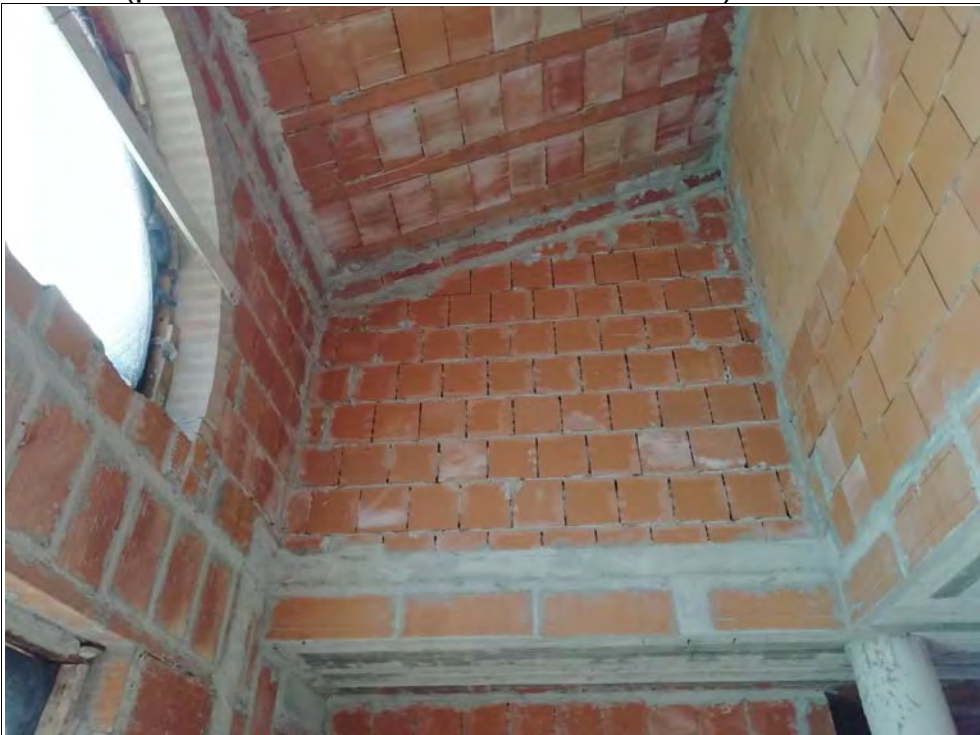
Foto 5: Particolare 4 del locale soggiorno (porzione a tutta altezza verso ovest)
