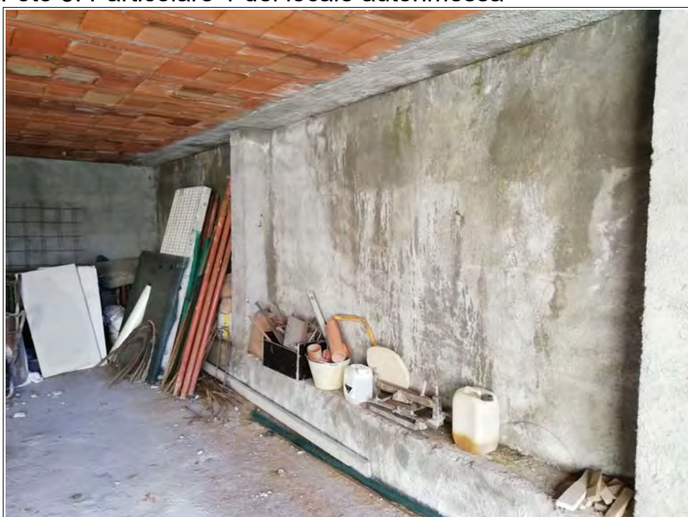
Foto 5: Particolare 1 del locale autorimessa
