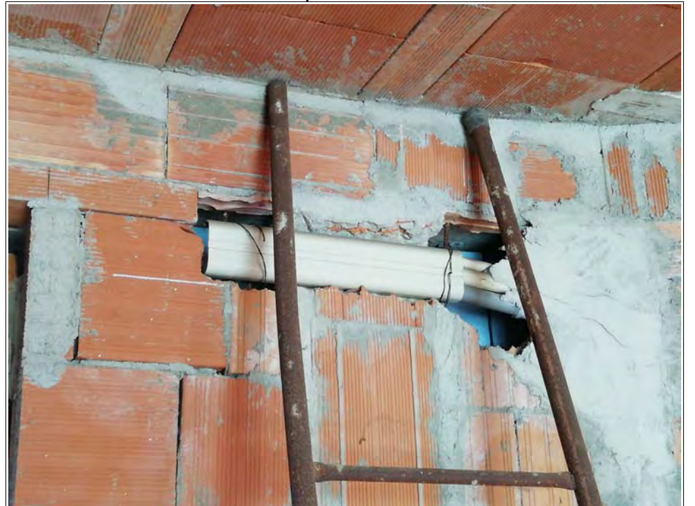
Foto 17: Particolare della rete fognaria interna
