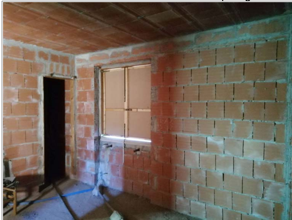
Foto 8: Particolare 1 del locale cucina e del ripostiglio 3
