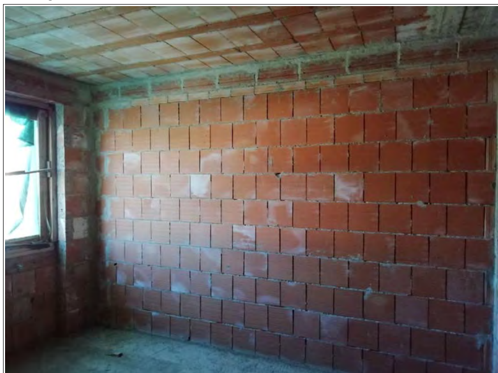
Foto 5: Particolare 1 del locale camera 2
