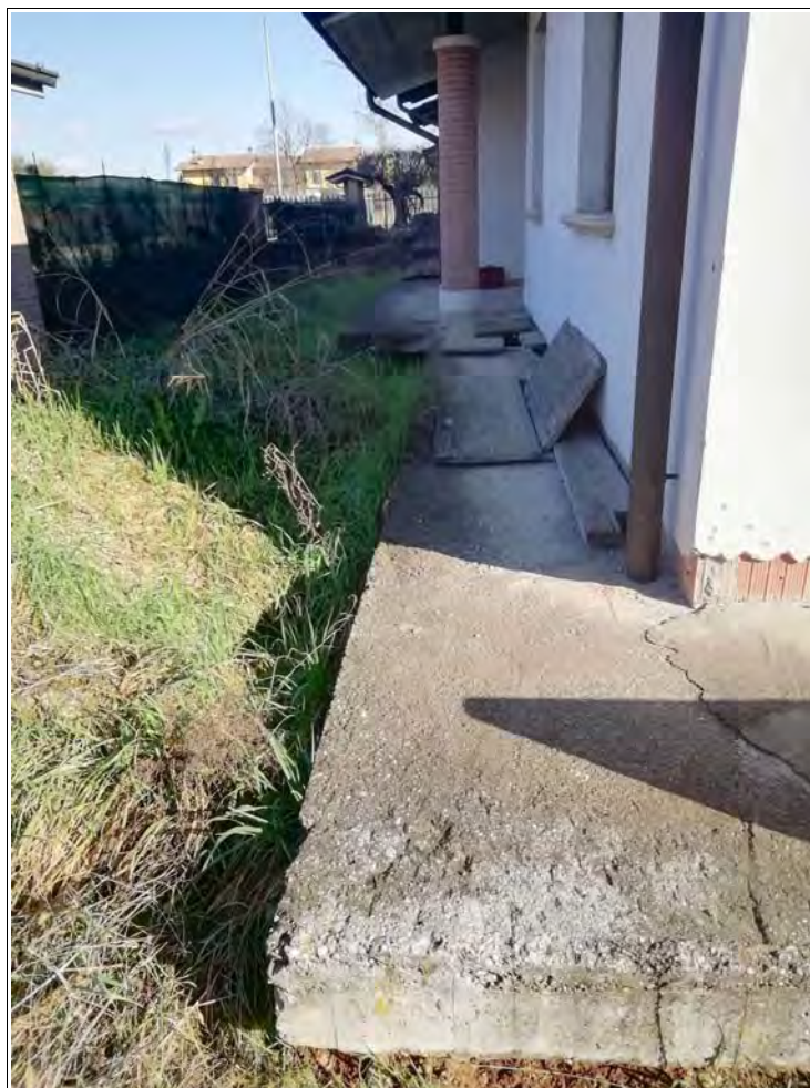
Foto 18: Particolare del marciapiede a sbalzo verso nord a quota del giardino
