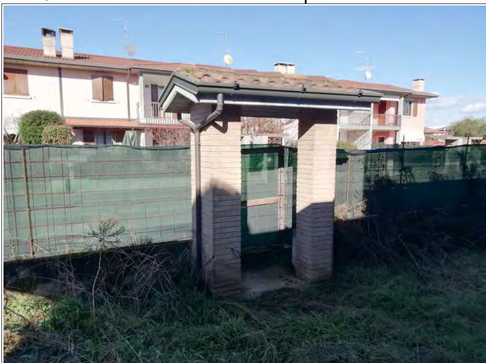
Foto 5: Vista della zona dell'accesso pedonale
