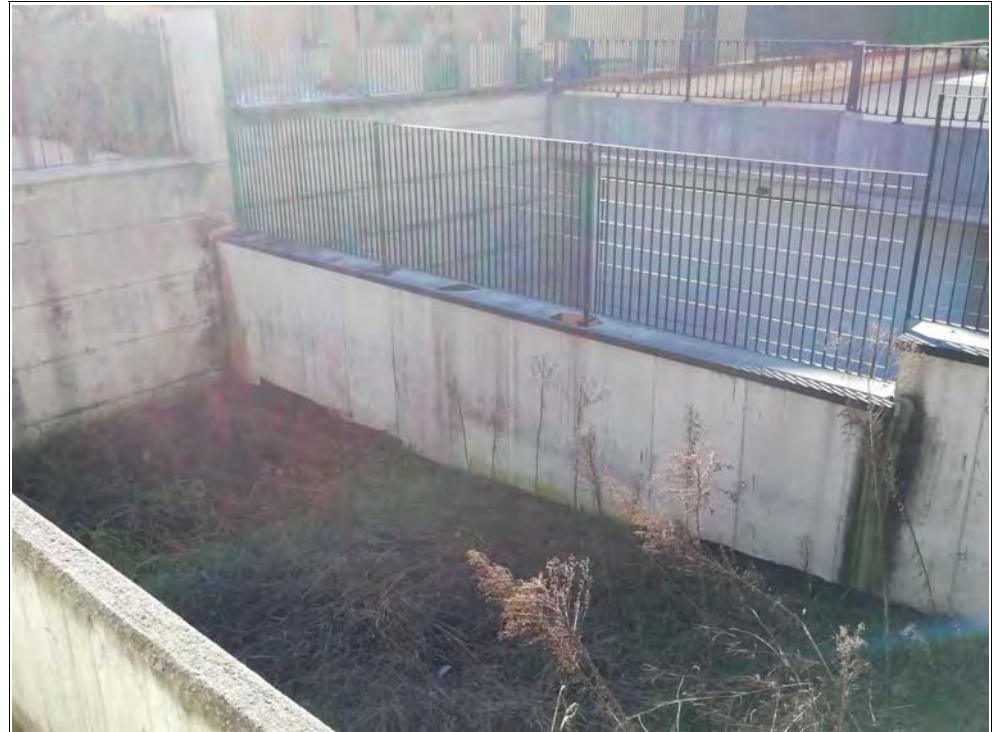
Foto 10: Vista 2 della zona destinata allo scivolo per l'accesso alla autorimessa
