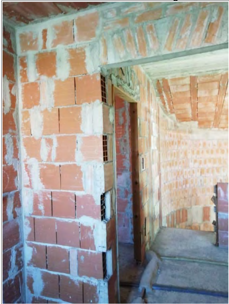
Foto 9: Particolare 3 del locale bagno
