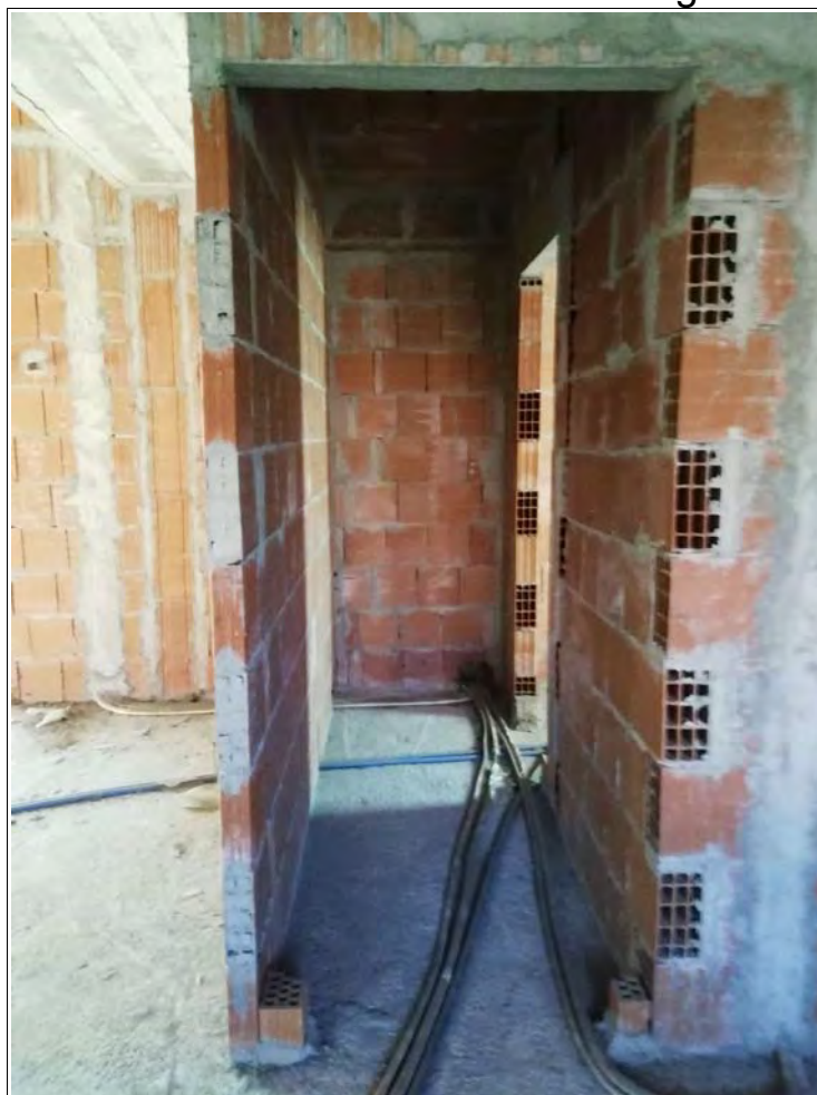
Foto 12: Particolare del locale antibagno
