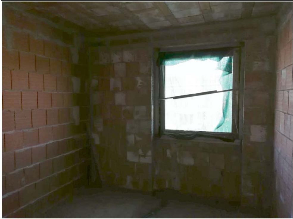
Foto 7: Particolare 1 del locale bagno
