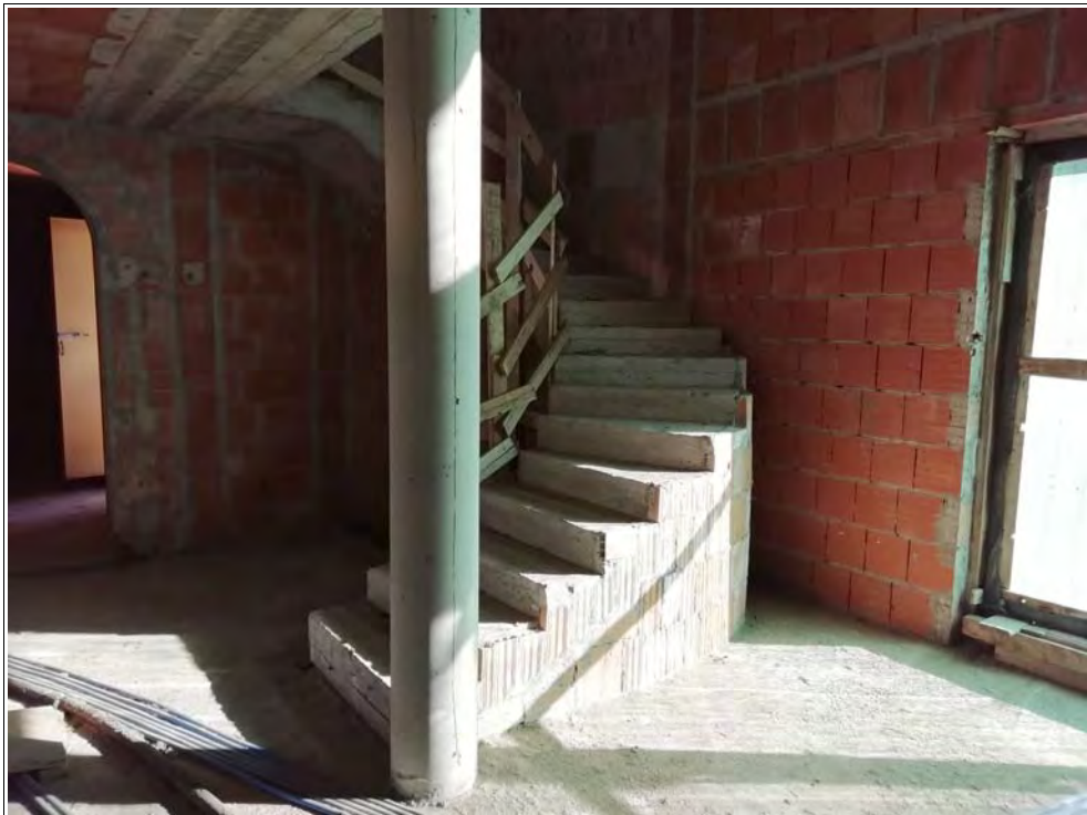
Foto 7: Particolare della scala PT-P1
