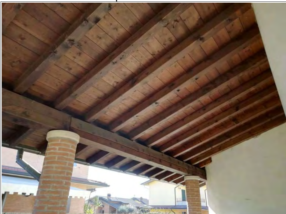
Foto 11: Particolare del portico verso sud
