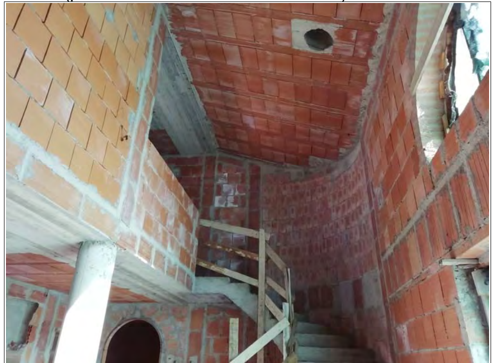
Foto 6: Particolare 5 del locale soggiorno (porzione a tutta altezza verso est)
