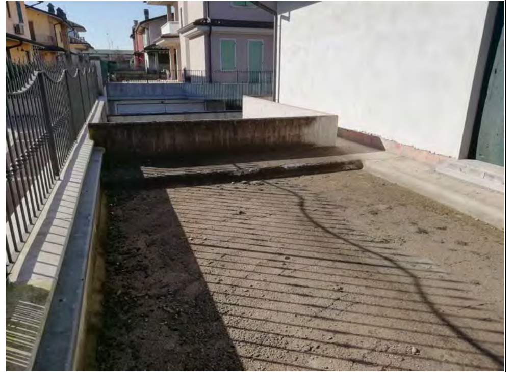
Foto 8: Vista del cortile soprastante all'autorimessa
