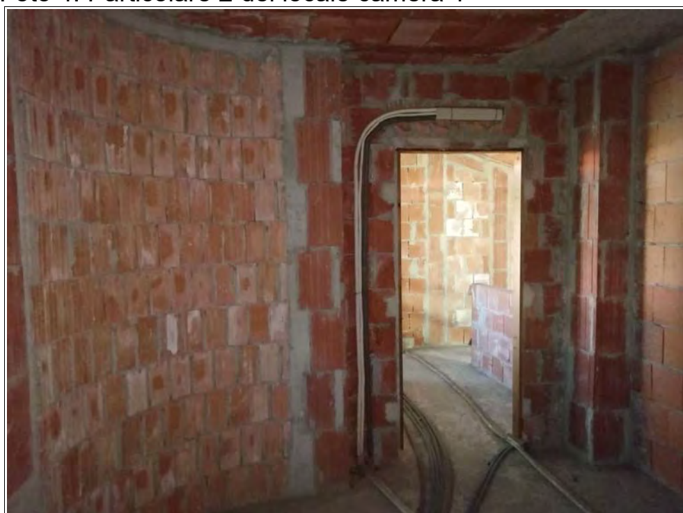
Foto 4: Particolare 2 del locale camera 1
