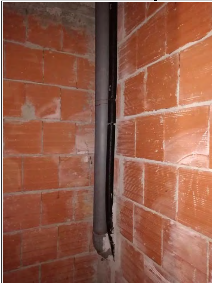
Foto 17: Particolare della rete fognaria interna
