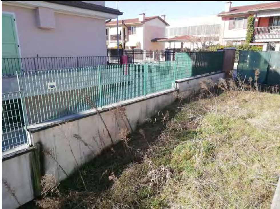
Foto 9: Vista 1 della zona destinata allo scivolo per l'accesso alla autorimessa
