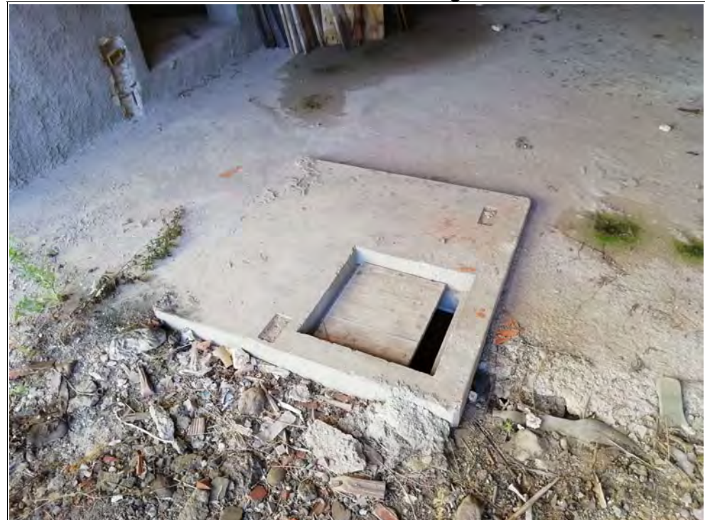
Foto 12: Particolare fossa della rete fognaria
