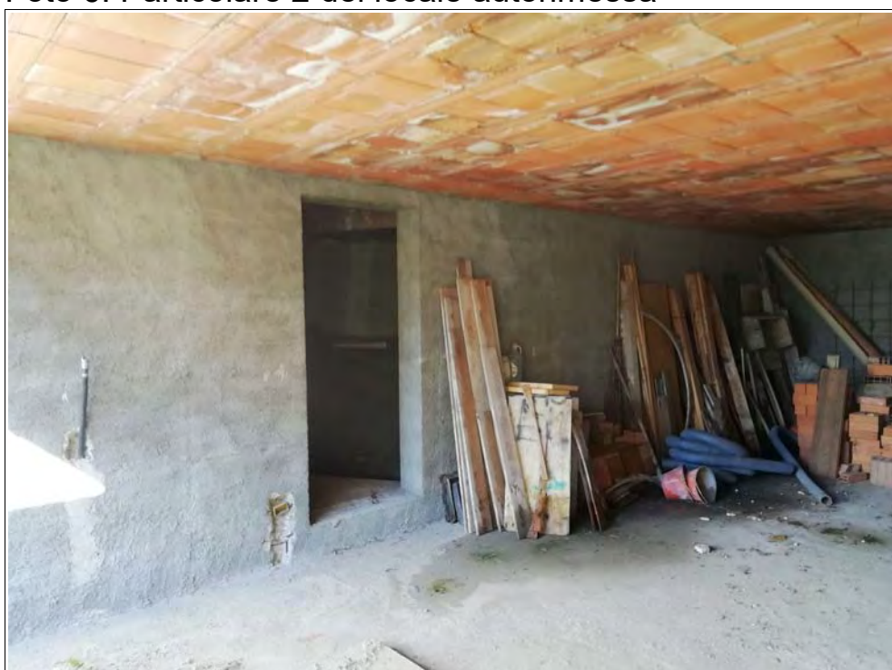
Foto 6: Particolare 2 del locale autorimessa
