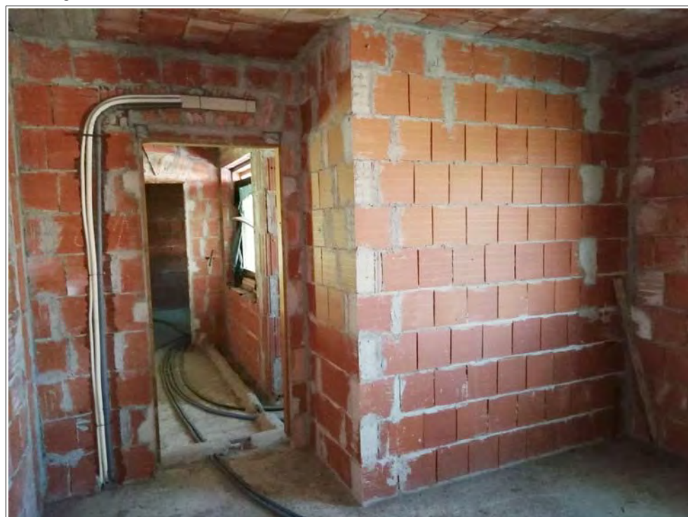
Foto 6: Particolare 2 del locale camera 2
