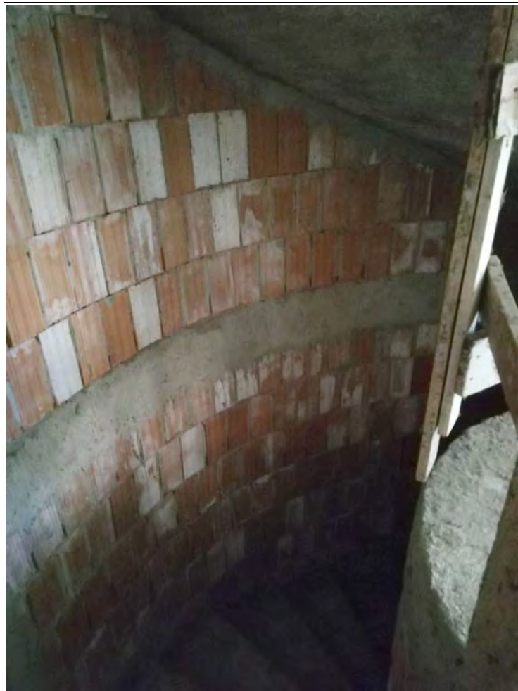
Foto 10: Particolare 2 della scala PS1-PT
