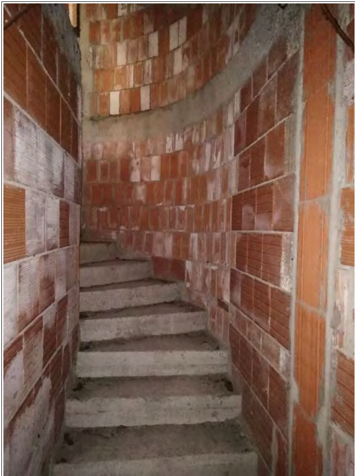
Foto 9: Particolare 1 della scala PS1-PT
