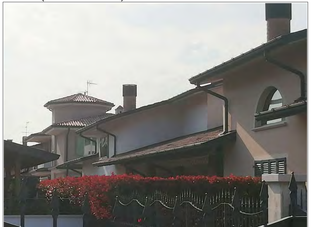
Foto 4: Vista del prospetto retrostante verso sud (da via Valenca)
