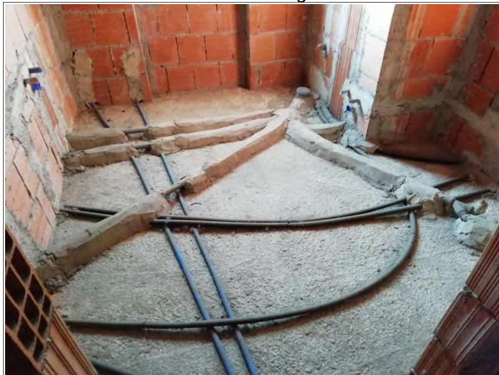
Foto 10: Particolare 1 del locale bagno
