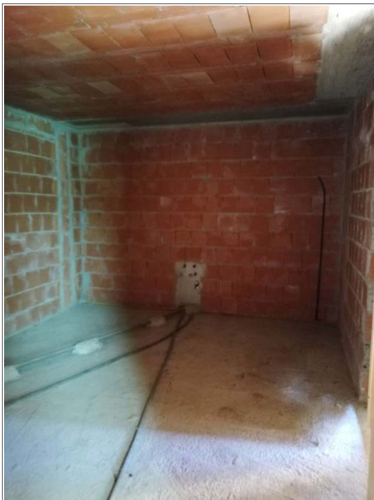
Foto 11: Particolare 3 del locale cucina
