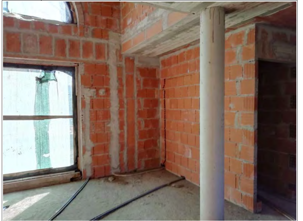
Foto 4: Particolare 3 del locale soggiorno (zona verso sud)
