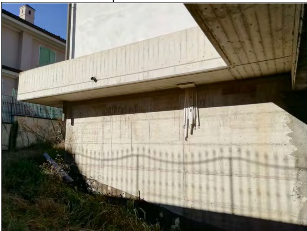
Foto 13: Vista del marciapiede a sbalzo verso la zona dello scivolo per l'accesso alla autorimessa
