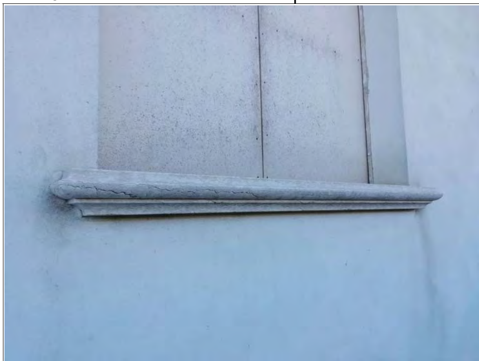
Foto 16: Particolare dei davanzali in pietra naturale
