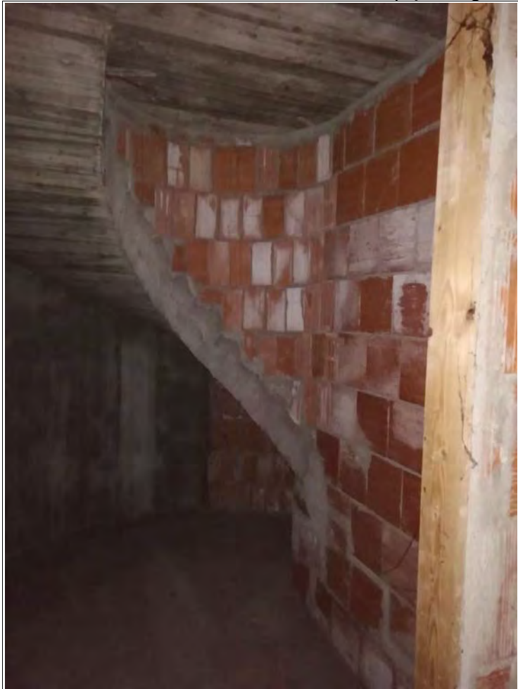
Foto 8: Particolare del sottoscala (ripostiglio 1)
