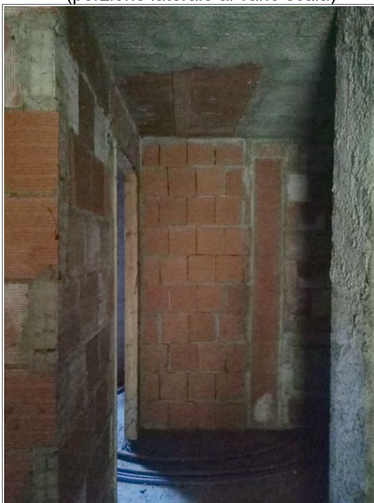
Foto 1: Particolare 1 del disbrigo (porzione laterale al vano scala)
