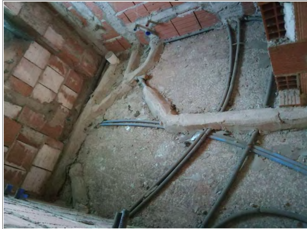
Foto 8: Particolare 2 del locale bagno
