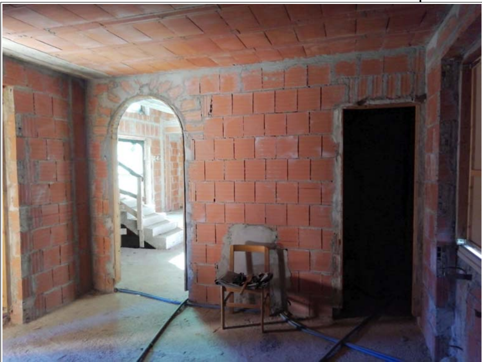
Foto 9: Particolare 2 del locale cucina e del locale rip. 3
