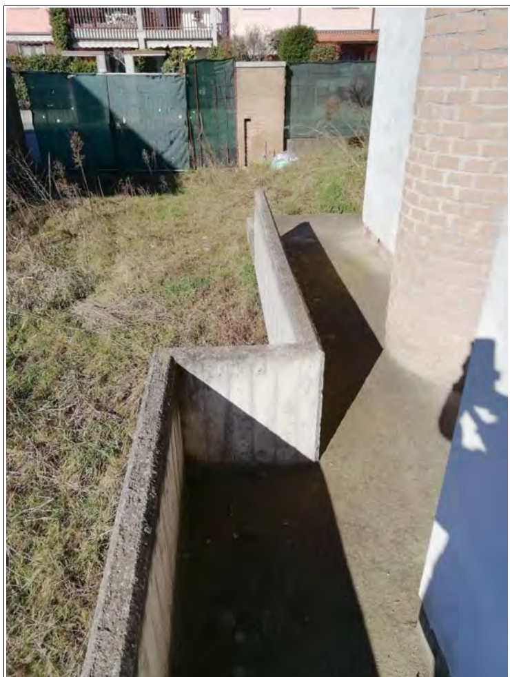
Foto 17: Particolare del parapetto del marciapiede verso ovest a sbalzo sullo scivolo per l'accesso alla autorimessa
