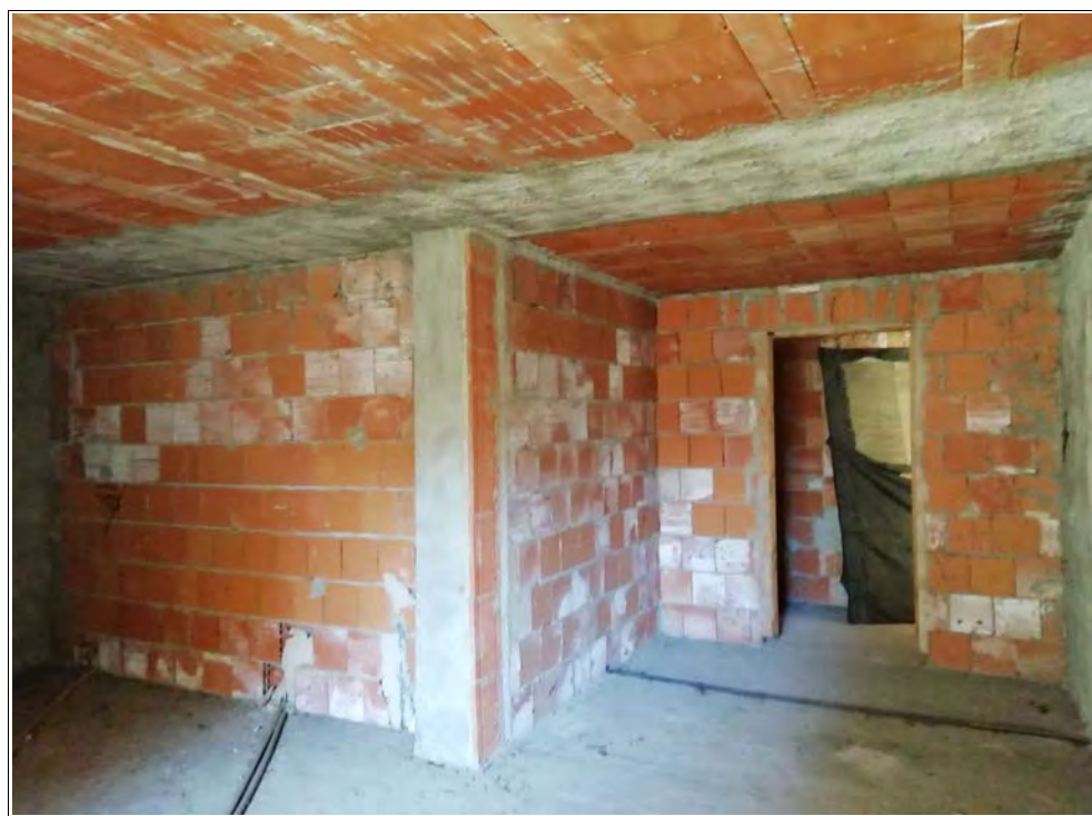
Foto 4: Particolare del locale cantina
