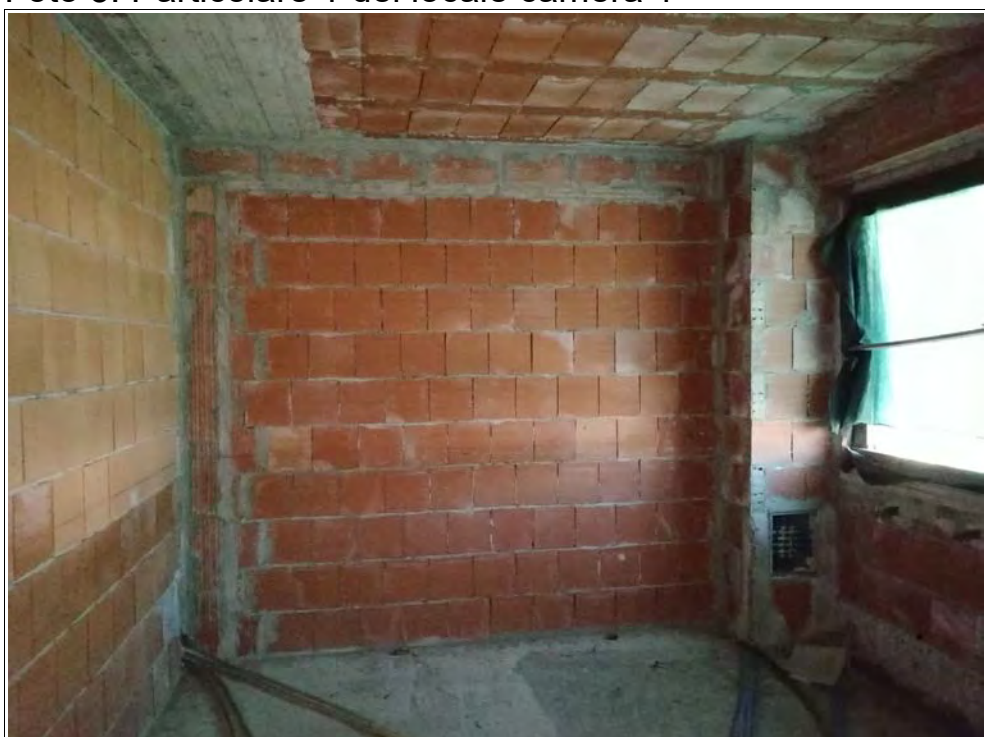
Foto 3: Particolare 1 del locale camera 1
