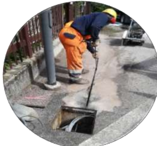
Esempio di nuovo scavo in tecnica di microtrincea
