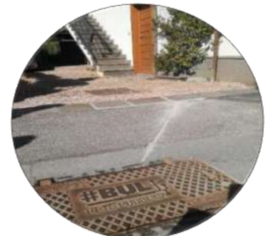
Esempio di scavo su proprietà pubblica e collegamento ad infrastruttura del privato
