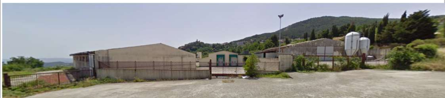
DOCUMENTAZIONE FOTOGRAFICA STATO ATTUALE
