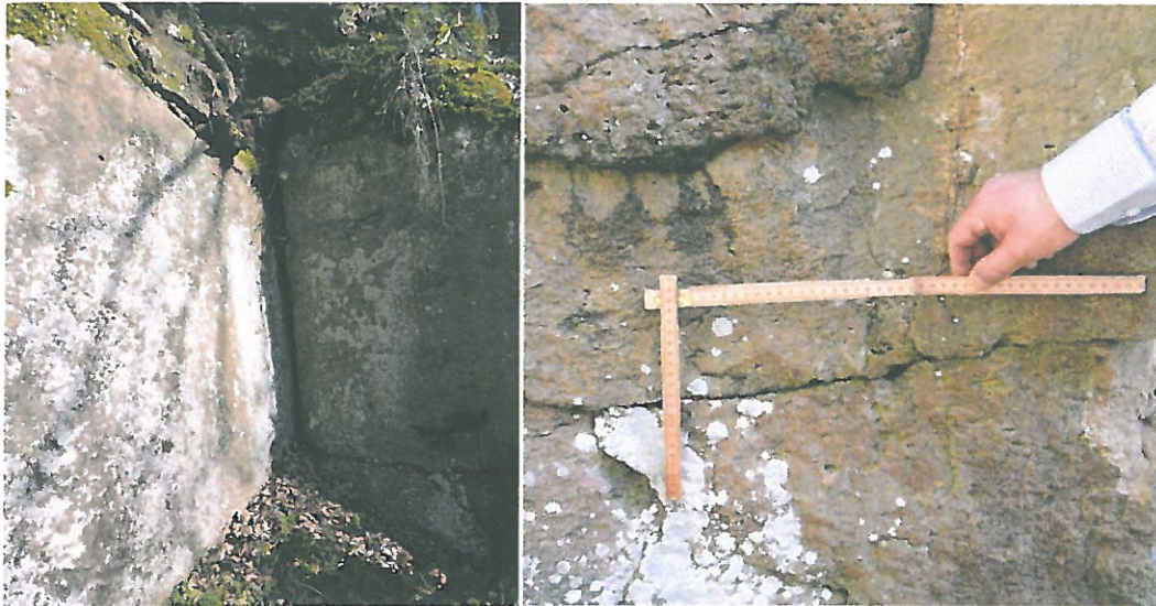
Fig. 2 – Sistemi di discontinuità sub-verticali e sub-orizzontali dell'Ignimbrite Cimina.
