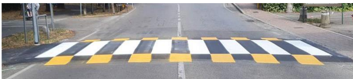
Figura 113: Soluzione comune per il segnalamento di un attraversamento pedonale rialzato
