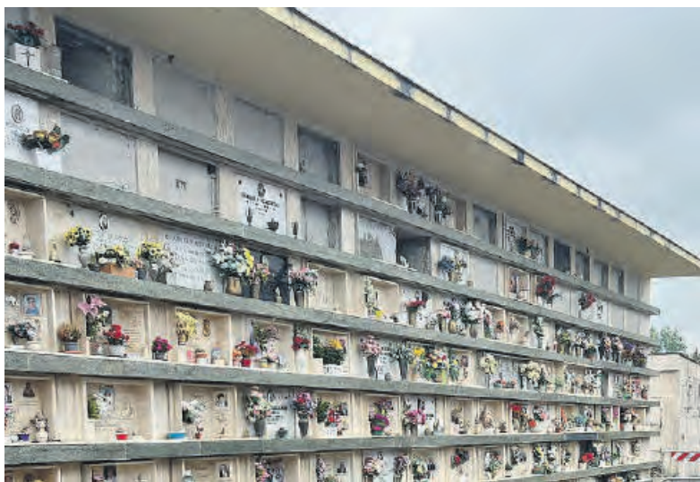
Continuano le segnalazioni di furti tra i loculi del cimitero di Cisterna
