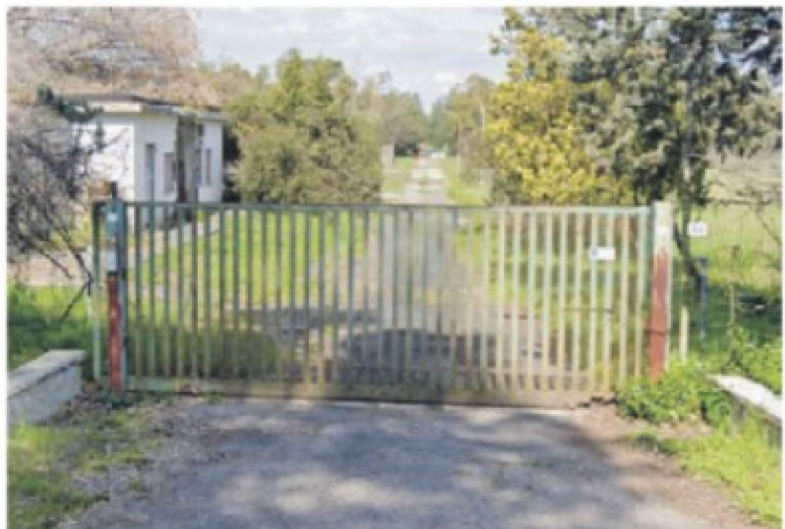
L'ingresso dell'ex polveriera in località Piano Rosso
