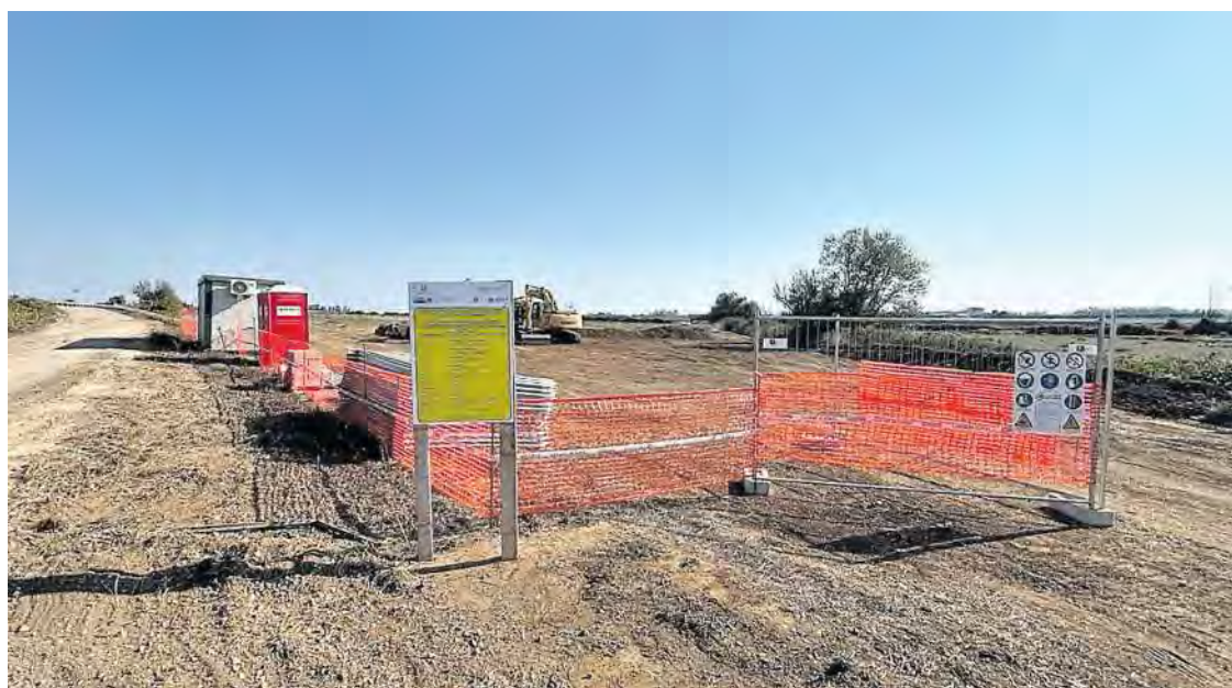
Il cantiere dello svincolo di Campoverde della bretella Cisterna-Valmontone
