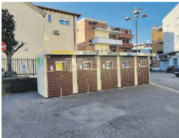
L'isola ecologica installata alle spalle della chiesa San Francesco d'Assisi di Cisterna
