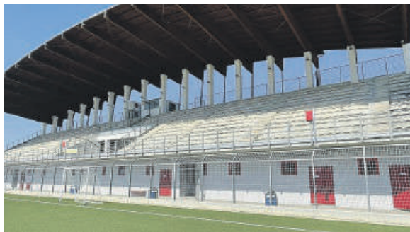
Lo stadio Domenico Bartolani di Cisterna
