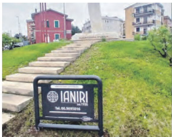
Nella foto sopra i lavori al monumento e sotto i lavori completati
