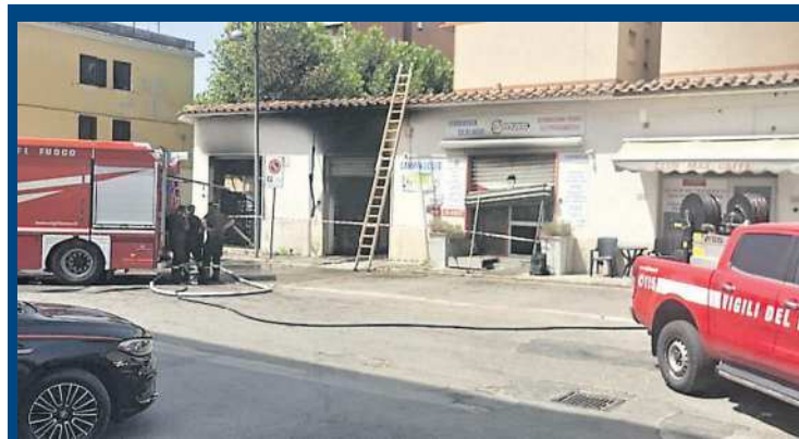
L'intervento dei vigili del fuoco sul doppio incendio che ieri mattina ha reso inagibile una frutteria e una ferramenta
