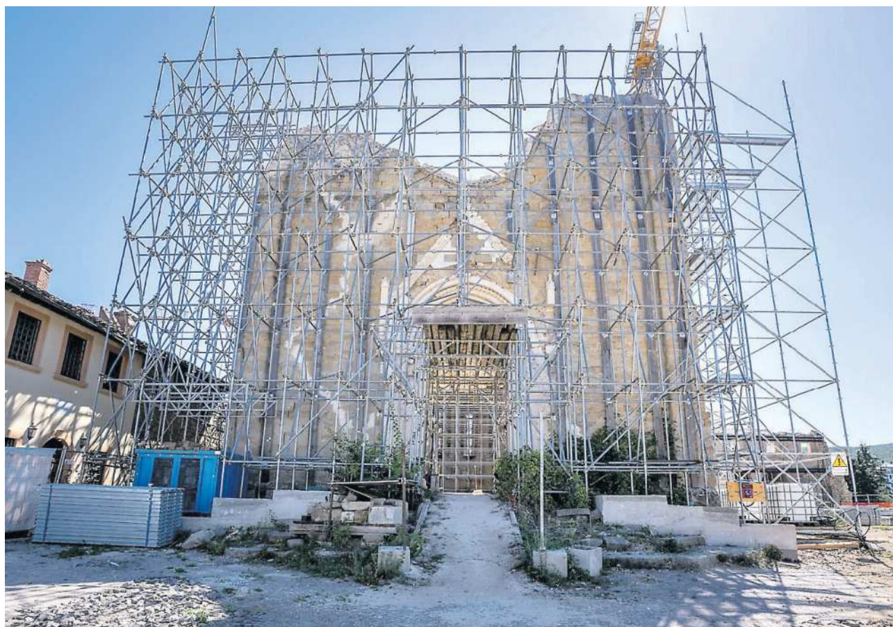
Il cantiere della ricostruzione della Chiesa di San Francesco ad Amatrice (foto FRACASSI/TOIATI)
