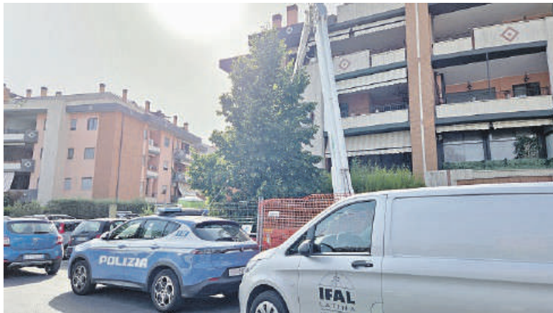
La tragedia consumata lunedì pomeriggio nel cantiere di viale Paganini in Q4
