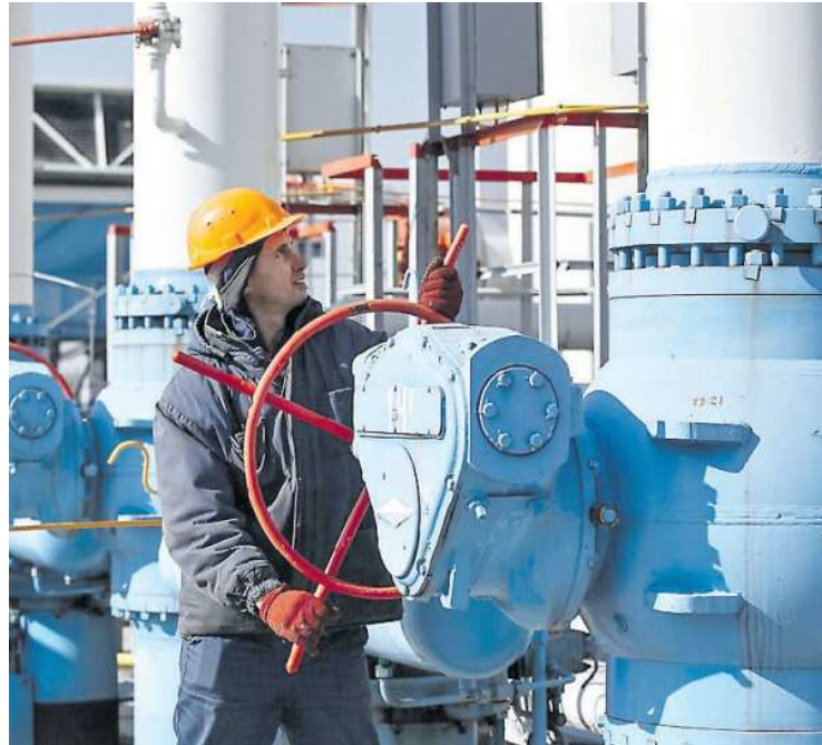
Un operaio al lavoro su una valvola di un gasdotto
