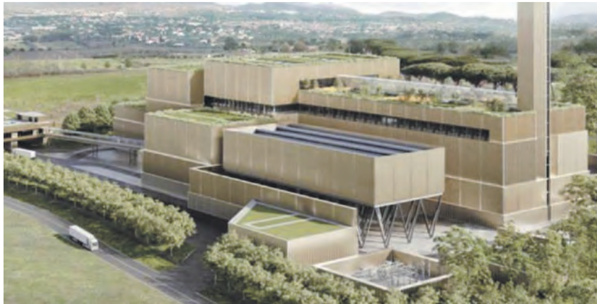
Un'immagine di un termovalorizzatore
