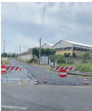
I lavori in via Civitona
