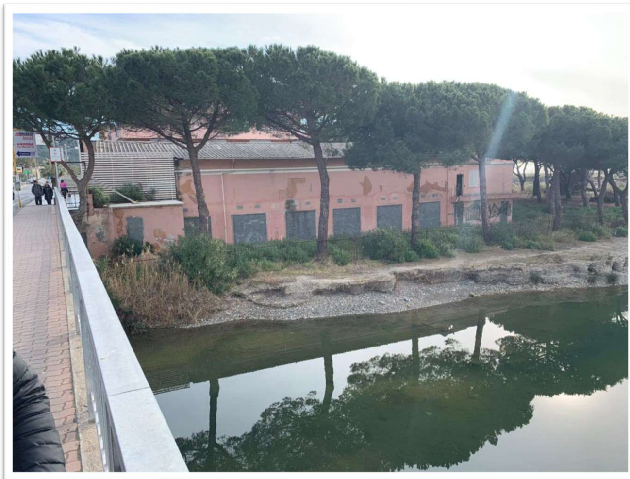
Fig. n: vista dei fabbricati dalla via Aurelia
