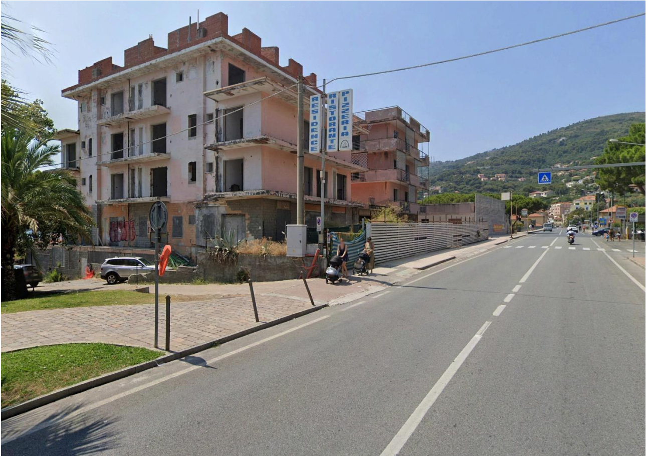
Vista dei fabbricati dalla via Aurelia
