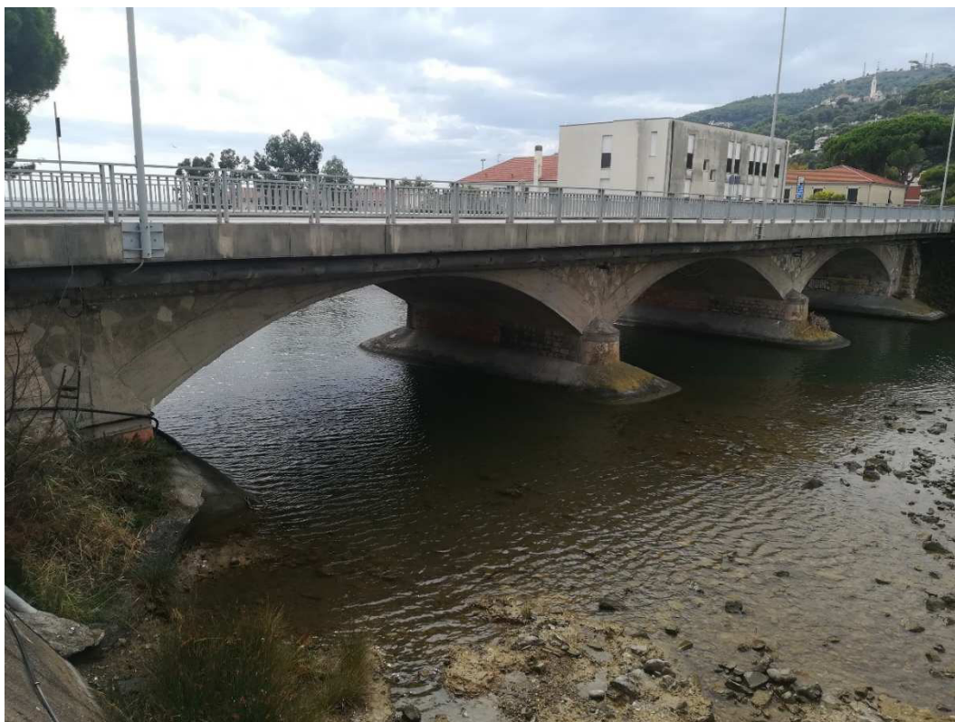
Fig. 5. vista ponte SS1 Aurelia
