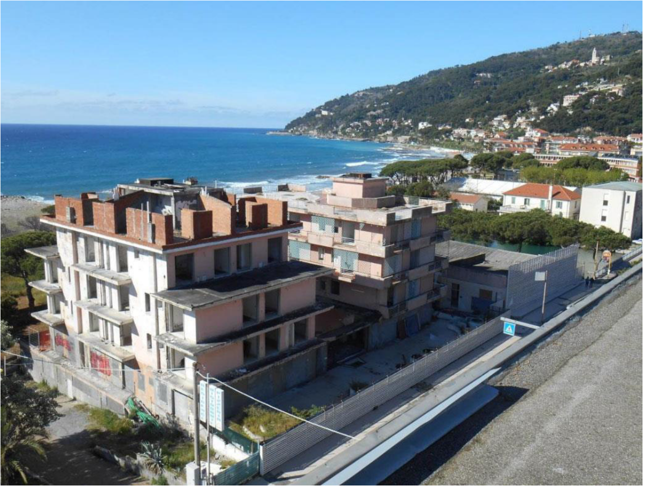
Vista dei fabbricati dalla via Aurelia
