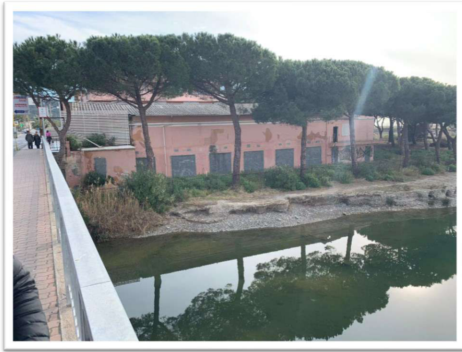
Fig. b: vista dell'area di intervento
