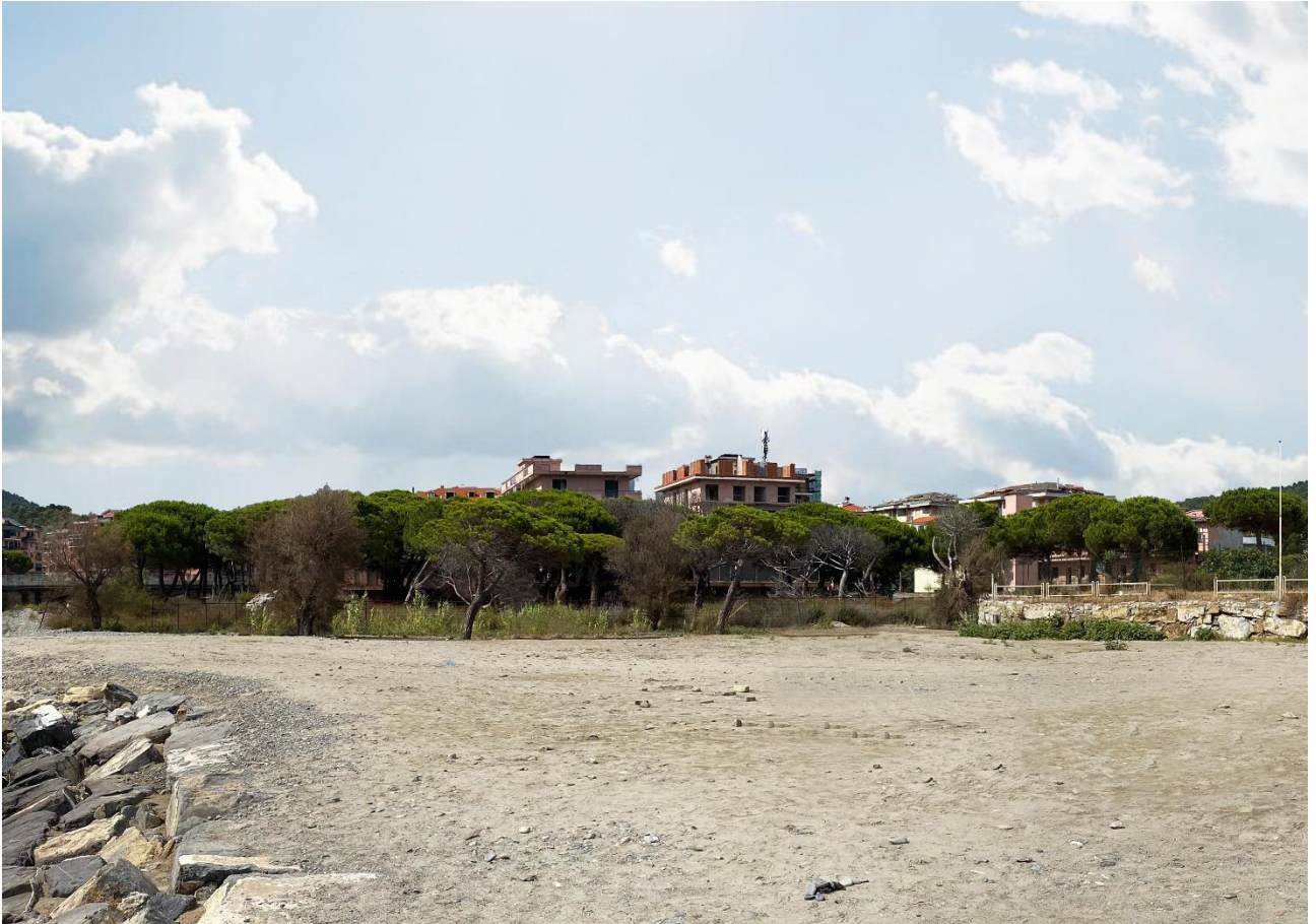
Vista dei fabbricati dal mare
