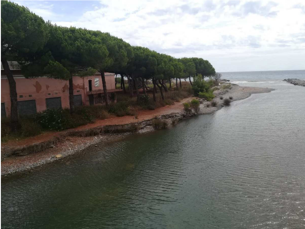
Fig. 9. Sponda sinistra a valle del ponte SS1 Aurelia
