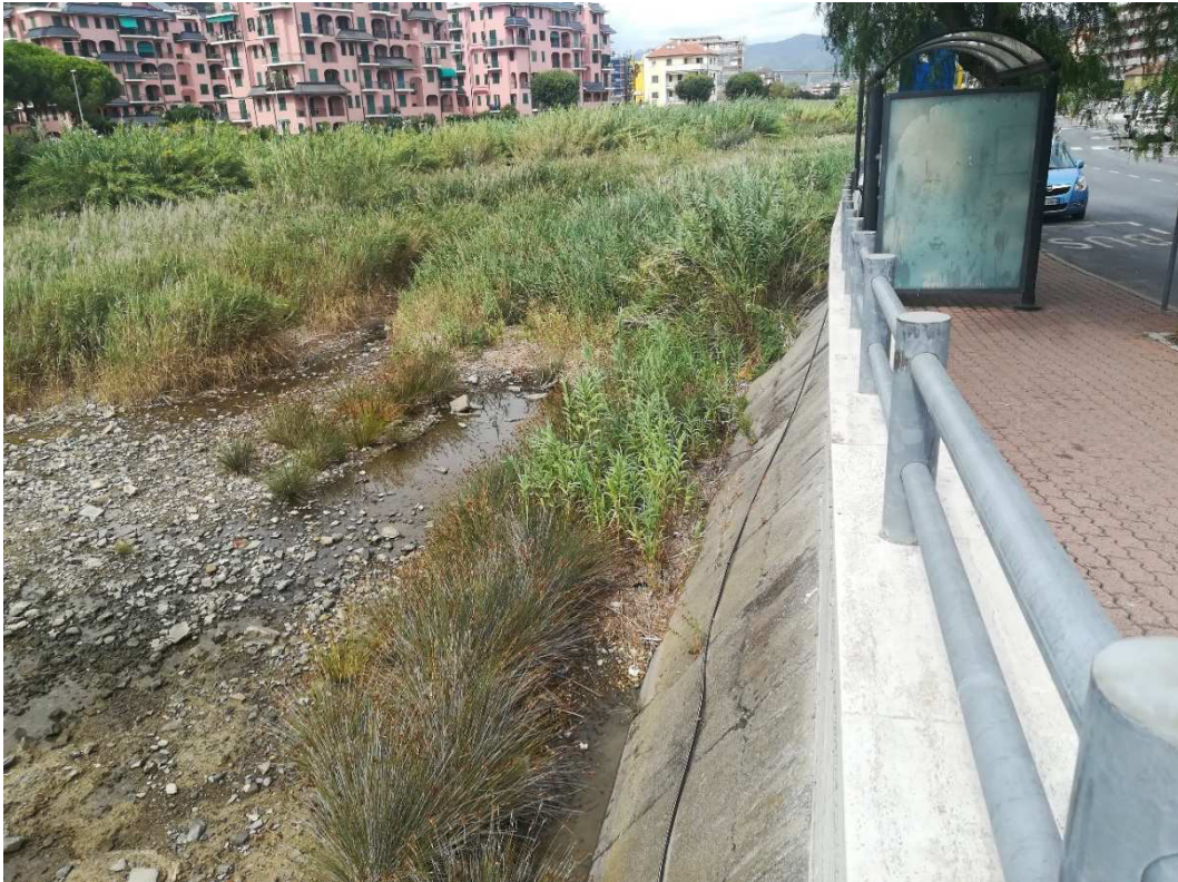
Fig. 4. Tratto arginatura sinistra a monte ponte SS1 Aurelia
