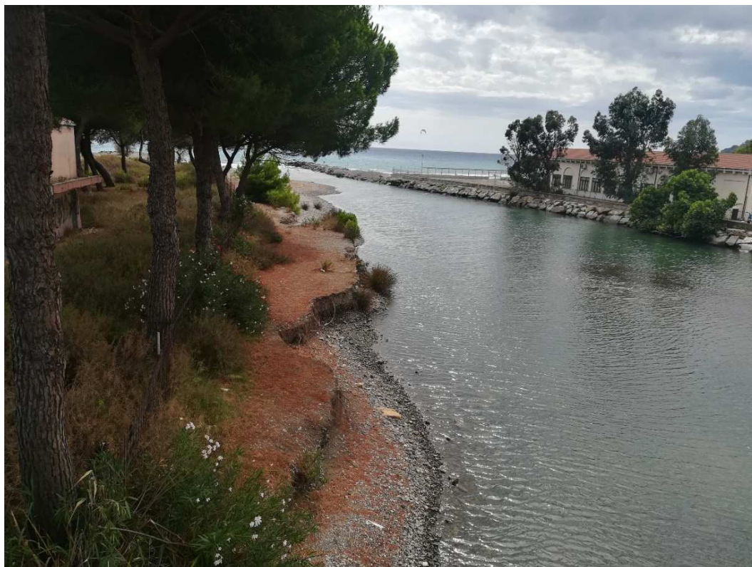
Fig. 8. Sponda sinistra a valle del ponte SS1 Aurelia
