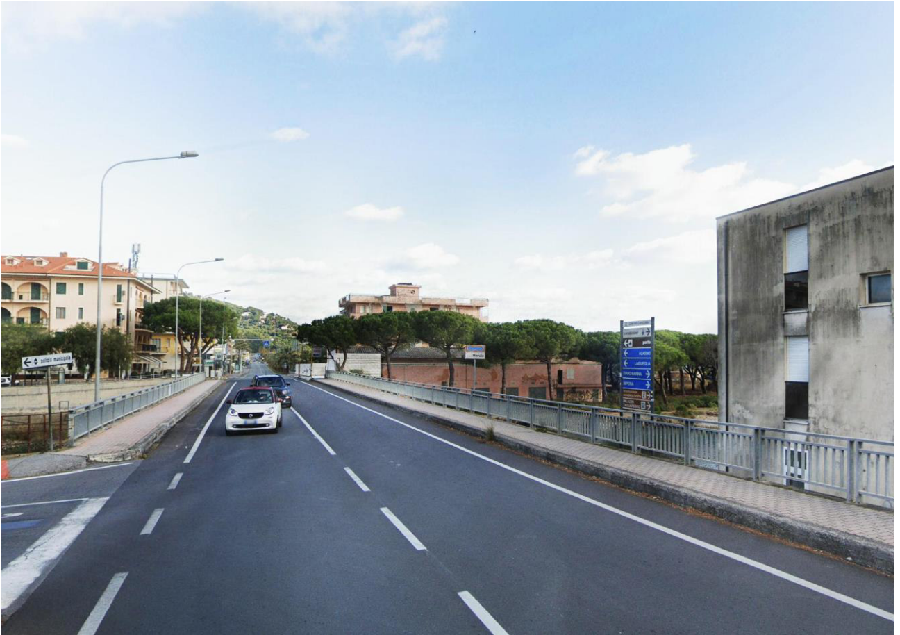
Vista dei fabbricati dalla via Aurelia
