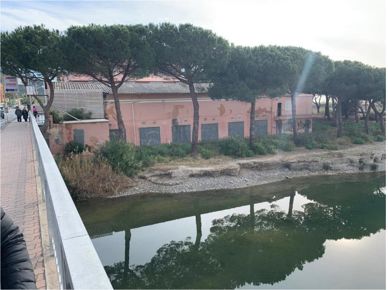
Vista dei fabbricati dalla via Aurelia
