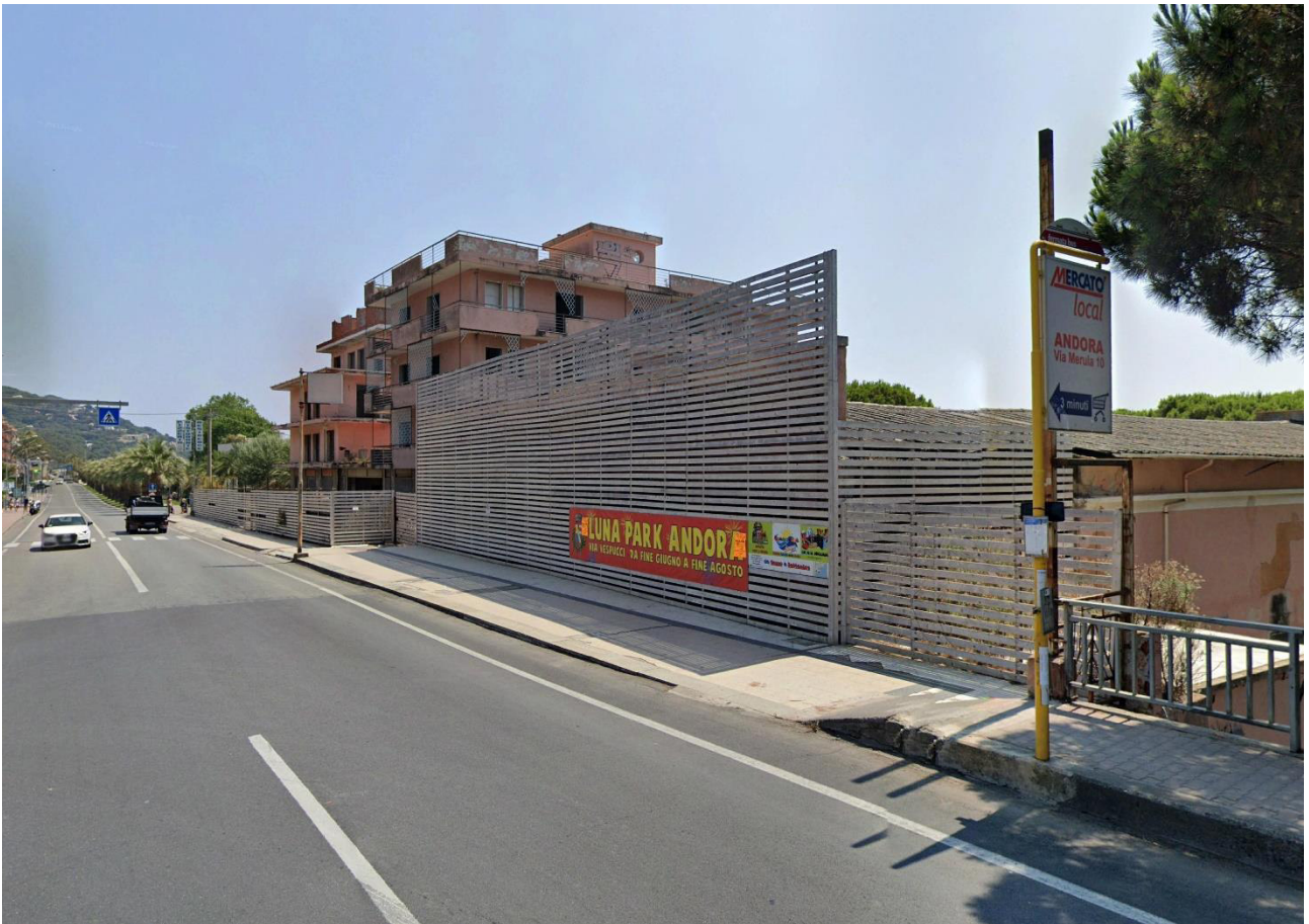
Vista dei fabbricati dalla via Aurelia
