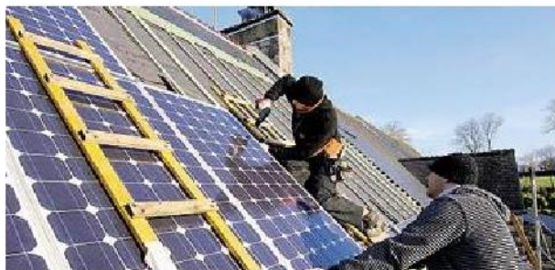
La posa di pannelli fotovoltaici sul tetto di un'abitazione
