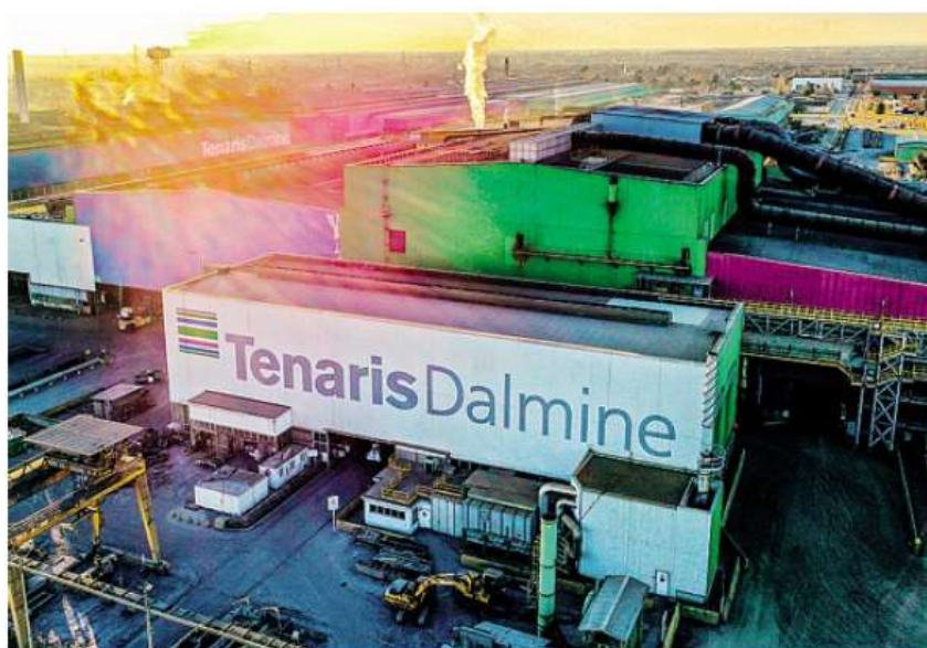
La TenarisDalmine negli stabilimenti italiani occupa oltre 2mila lavoratori
