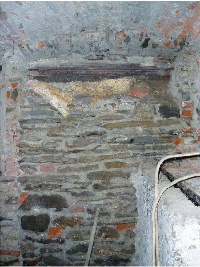
Particolare della muratura e del solaio del piano interrato.
