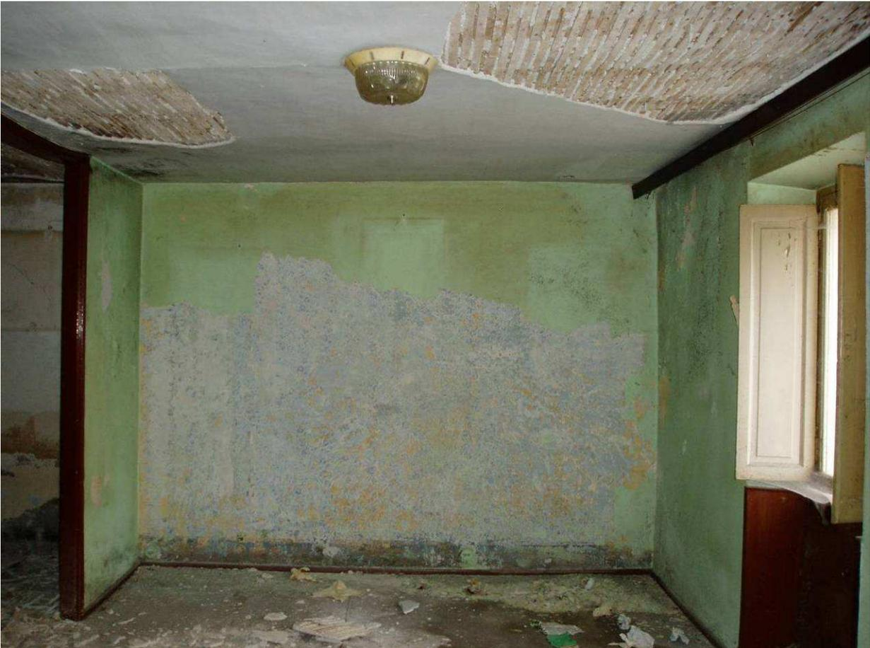
Vista di uno dei locali interni con in evidenza il solaio in listelli e intonaco.
