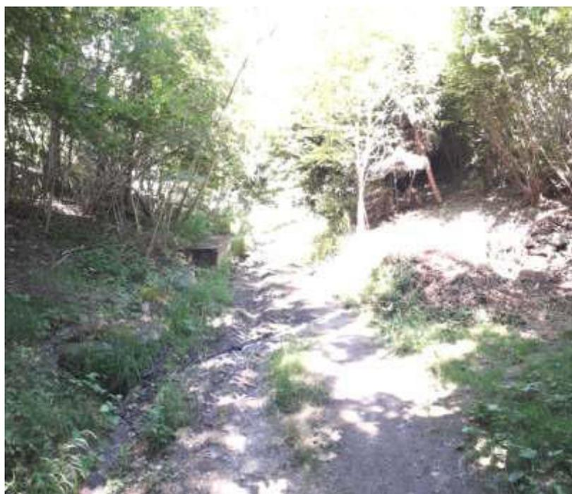
**FOTO 38-39:** tracce di ruscellamento lungo la pista sterrata, al contorno della quale sono presenti alcune sorgenti. Canaline in metallo raccolgono le acque e le convogliano verso il canale.
