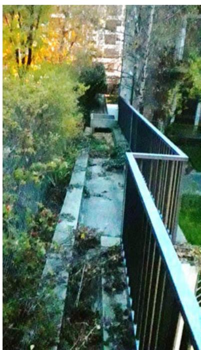
Foto 65-66: Rio Bibian: canalizzazione di troppopieno del rio diretta verso via Roma, posta in testa alla muratura di confine, all'interno della quale corre la tubazione di deflusso delle acque.
