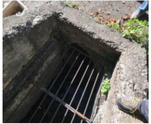
**FOTO 24-25:** attraversamento del rio Champailler in loc. Pallin, a quota 650 m in tubazione con diam. 1000 mm.
