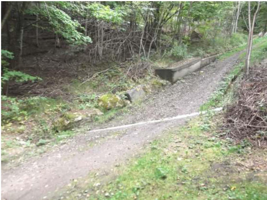
**FOTO 37:** rio Bibian incanalato a monte di Arpuilles (q. 1100 m) lungo la ripida pista che sale a monte del villaggio. In questo punto il canale si immette nella tubazione che prosegue sotto il villaggio.
