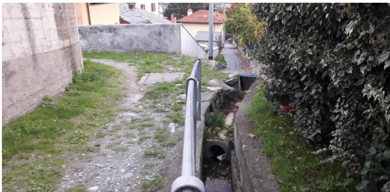
Foto 62: Rio Bibian: canale con tubazione all'interno a valle di via Edelweiss. Subito a valle si nota l'imbocco dell'ampio canale grigliato che porta su viale G.S. Bernardo.
