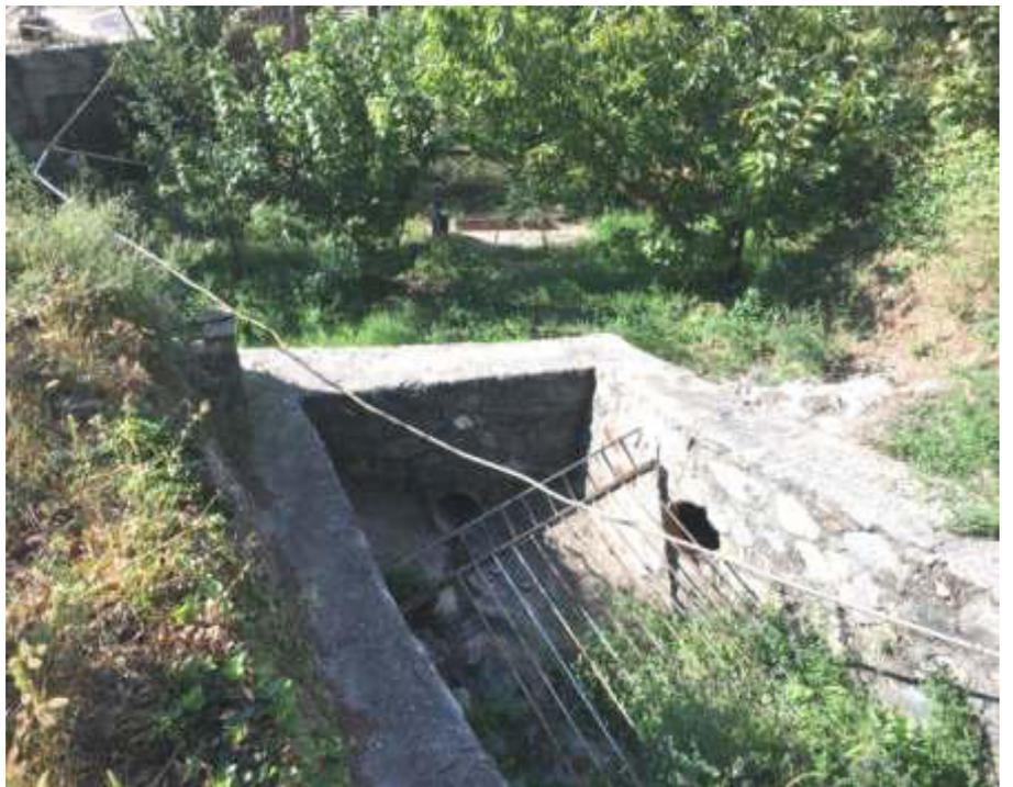
**FOTO 26-27:** tratto incanalato del rio Pallin tra le quote 650-640m che termina in un pozzetto dotato di griglia sghiaiatrice e con due tubazioni da 380 mm e troppopieno a quota più alta.
