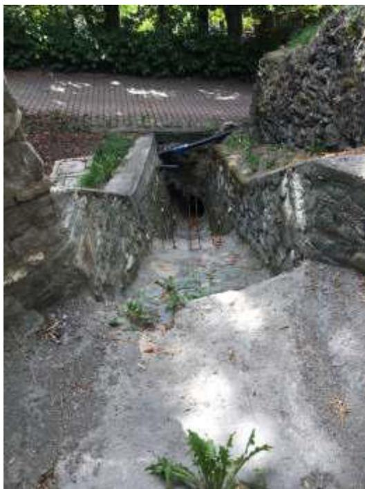
**FOTO 18-19:** attraversamenti del rio Champailler in prossimità di dell'omonima località: a quota 860 m (sx) attraversa la viabilità regionale in un ampio scatolare in c.a.; subito a valle (q. 820 m, supera la strada vicinale di accesso alla case in tubazione da 500mm.
