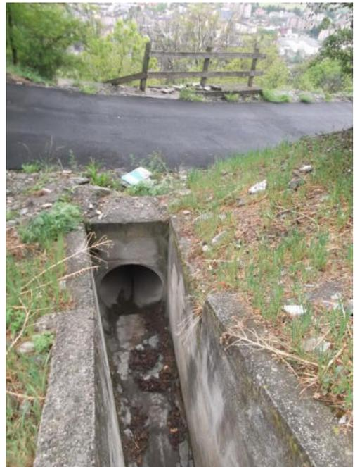
Foto 54-55: Rio di Cossan: canalizzazione e attraversamento lungo la strada vicinale a valle del tornante della S.R. a Champailler .
