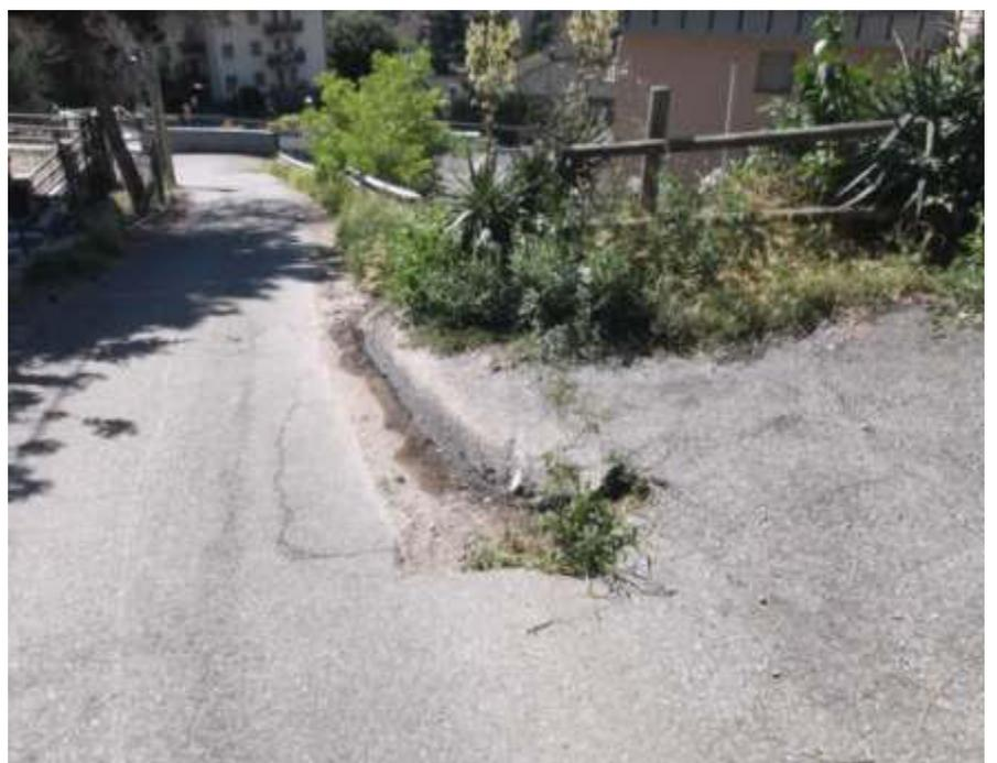
**FOTO 34-35:** rio Collignon nel settore antropizzato, che corre intubato sotto la viabilità e in un canale che costeggia il muro di controripa di un complesso di condomini.
