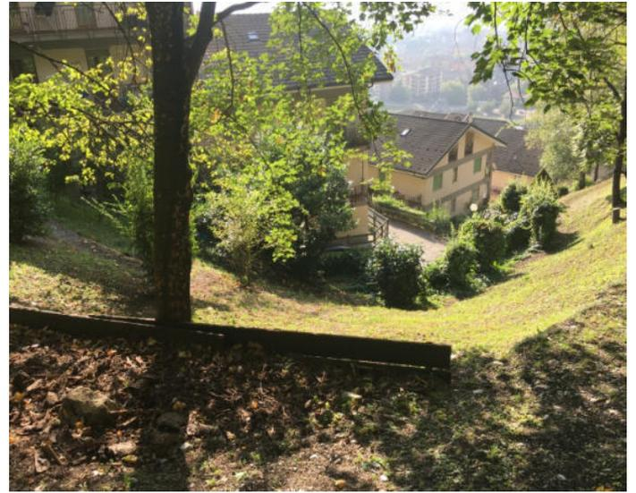
**FOTO 8-9:autorimesse nell' incisione del Rio Bioula alla quota 696 m (sx) e impluvio occupato da aree verdi degli edifici a quota 650 m, caratterizzato dalla presenza di opere trasversali in legno (dx) di regimazione delle acque di pioggia.**
