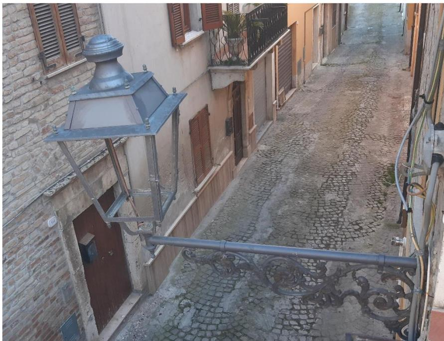
L'impianto di pubblica illuminazione è stato recentemente efficientato mediante sostituzione di corpo illuminante del tipo sodio ad alta pressione con nuove piastre LED inserite all'interno delle lanterne artistiche esistenti.
