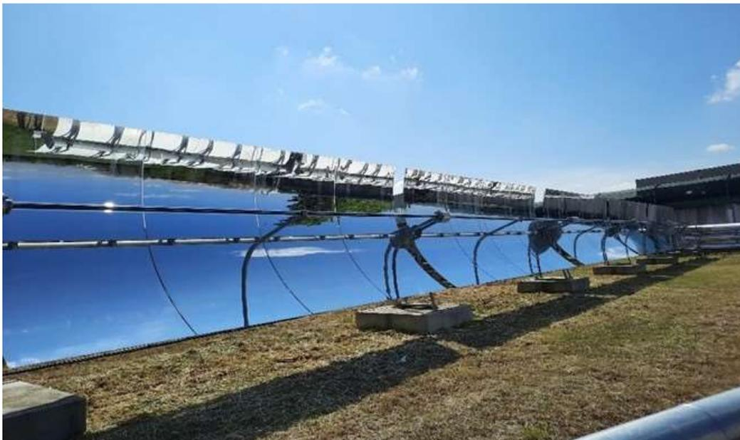
Figura 22 - Specchi che concentrano la radiazione luminosa
