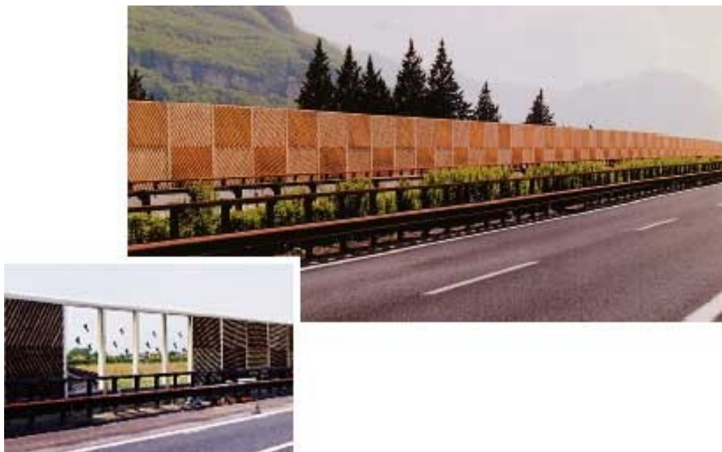
Figura 1 Barriera artificiale in legno
