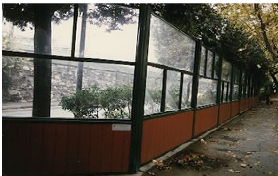
Figura 2 Esempio di barriera fonoassorbente realizzata con pannelli trasparenti
