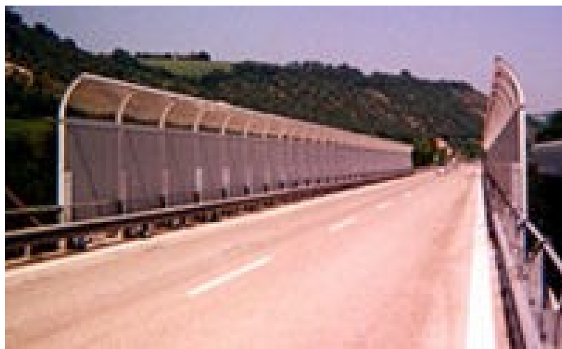
Figura 4 Barriere in lamiera metallica
