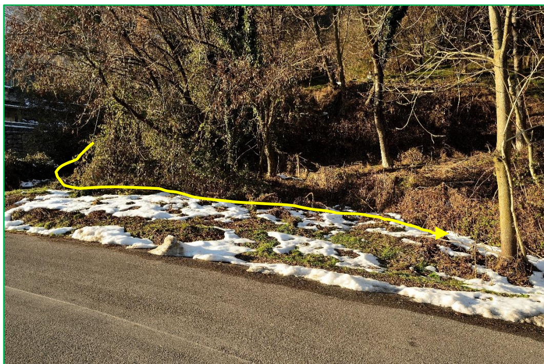
Figura 44 – Punto critico ATT_02 alla “Bretella del Farno”: la valletta devia di circa 90° e segue una modestissima incisione fino a re-immettersi in un tombotto ostruito dalla vegetazione; il dislivello rispetto alla sede stradale è molto limitato e potrebbe dare luogo ad esondazioni
