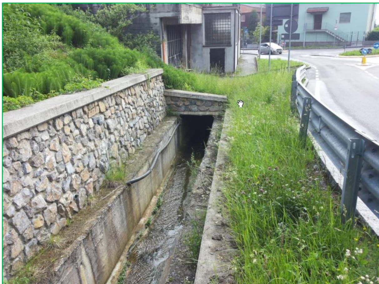
Figura 30 – Tombotto del T. Re in Via Milano, sede di possibile occlusione e conseguente esondazione
