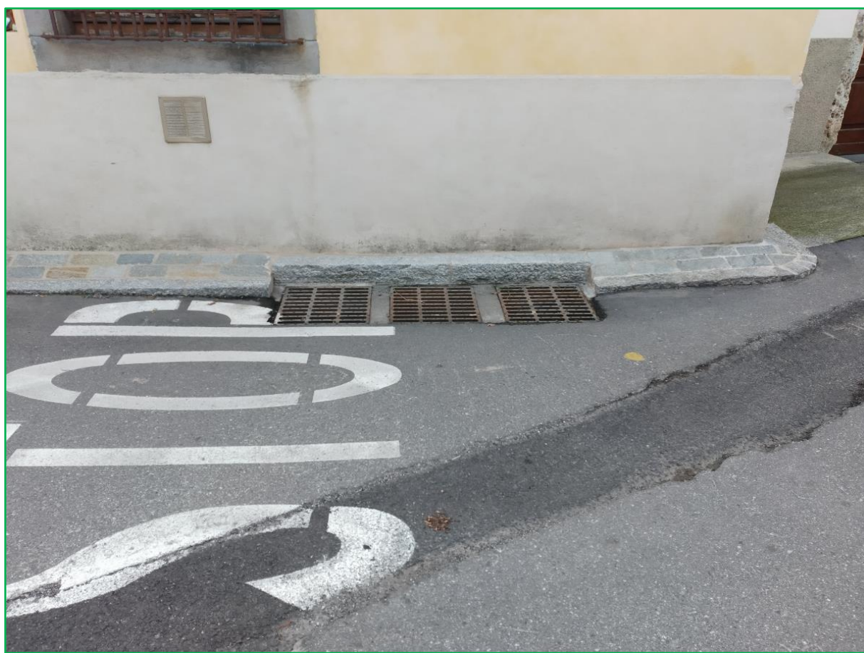
Figura 72 - Caditoie stradali poste sul lato posteriore della chiesa, all'inizio di Via Monte Grappa
