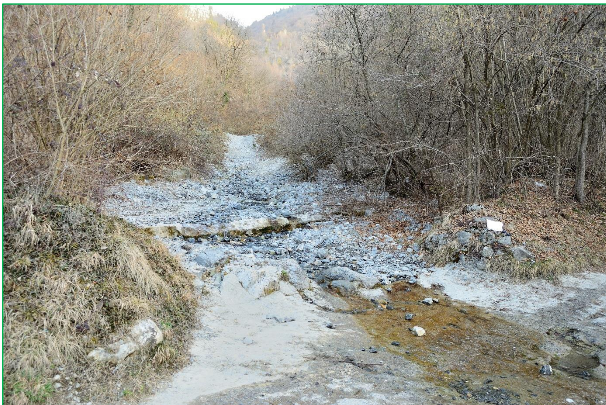
Figura 57 - La Val Groaro all'intersezione con la strada di Val d'Agro in località Groaro Il guado, oltre ad essere ammalorato, è completamente esposto ad eventuali fenomeni di debris flow, oltre che meramente esondativi
