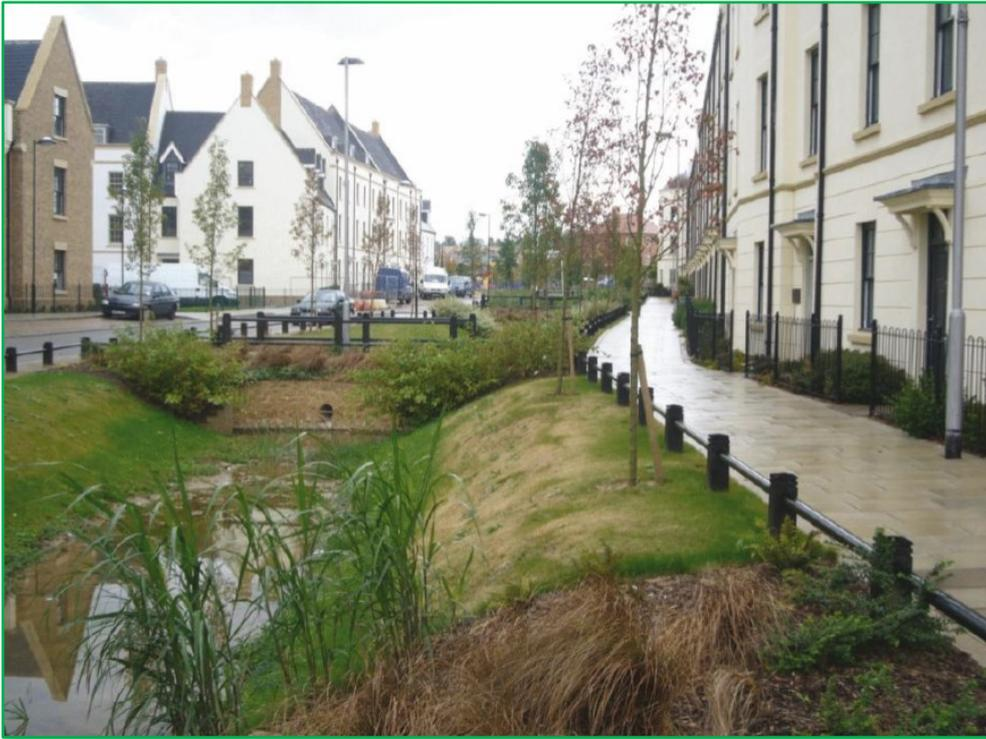
Figura 143 - Esempio di via d'acqua per il drenaggio urbano delle acque meteoriche
