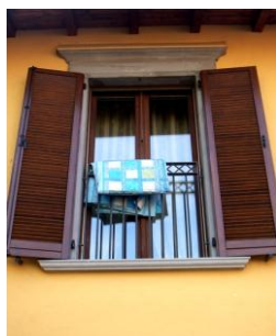
n. 4 (dettaglio finestra)
