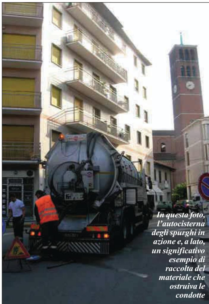
*In questa foto, l'autocisterna degli spurghi in azione e, a lato, un significativo esempio di raccolta del materiale che ostruiva le condotte*
