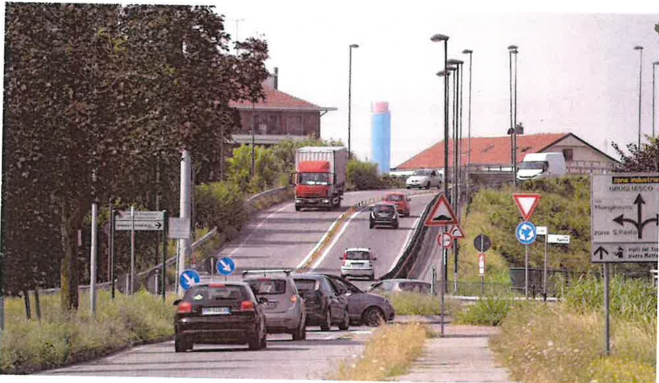
Il cavalcaferrovia di corso Torino a Grugliasco
