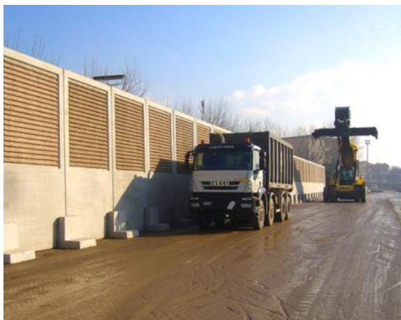
ESEMPI DI BARRIERA ANTIRUMORE FISSA, DI CANTIERE, AUTOSTABILE, SU MAGRONE DI FONDAZIONE
