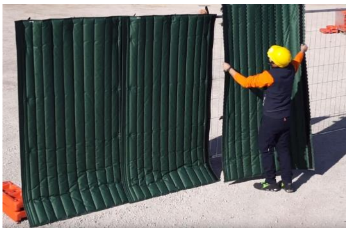
ESEMPI DI BARRIERA ANTIRUMORE MOBILE, DI CANTIERE, RAPIDA
