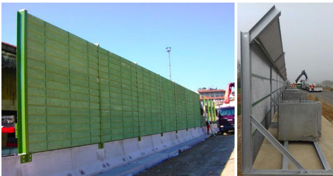
ESEMPI DI BARRIERA ANTIRUMORE MOBILE, DI CANTIERE, AUTOSTABILE IN METALLO
