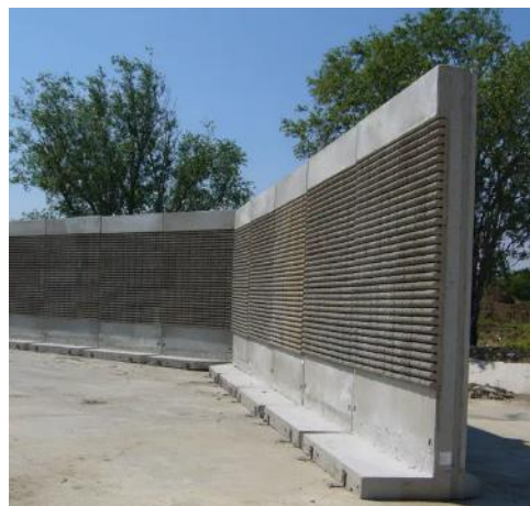
ESEMPI DI BARRIERA ANTIRUMORE FISSA, DI CANTIERE, AUTOSTABILE, SU MAGRONE DI FONDAZIONE
