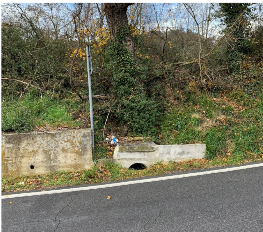
Figura 16: Pozzetto di raccolta al km 7+400 lato monte
