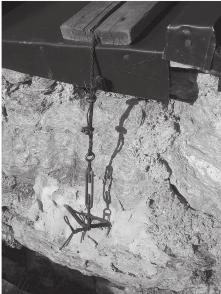
Figura 7.1.: Ancoraggio del tetto mediante cavo in acciaio.
