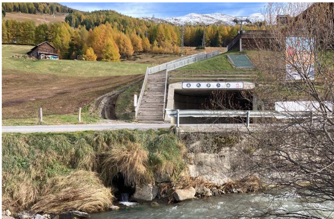
Figura 4.15: Sbocco del Rin dal Domenin nel T. Spöl tramite tubazione in cls
