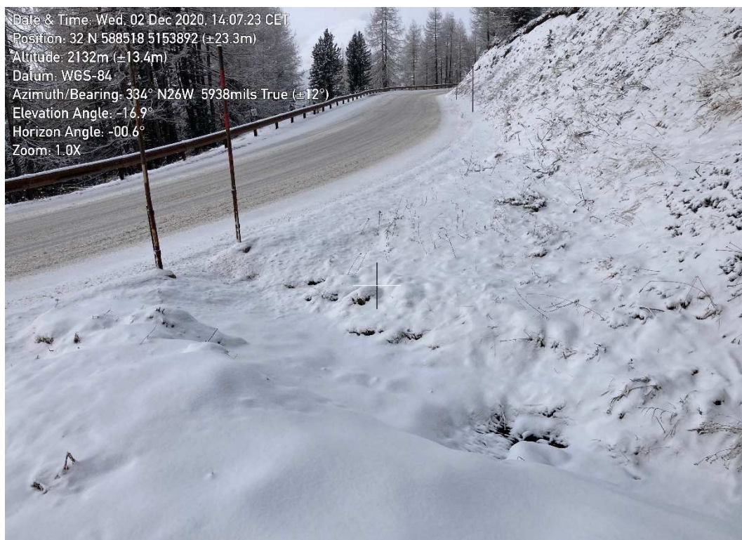
Figura 4.5: griglia di raccolta a monte del tombotto stradale
