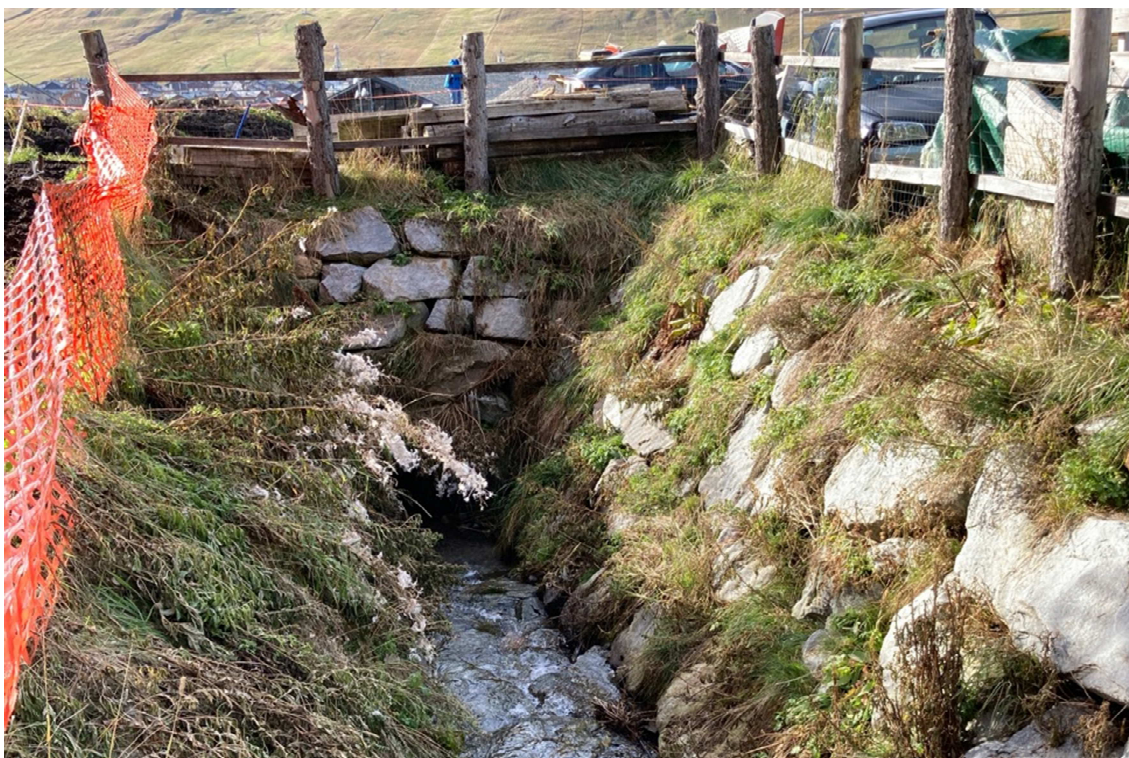
Figura 4.17: Vasca d'imbocco al tratto tombato
