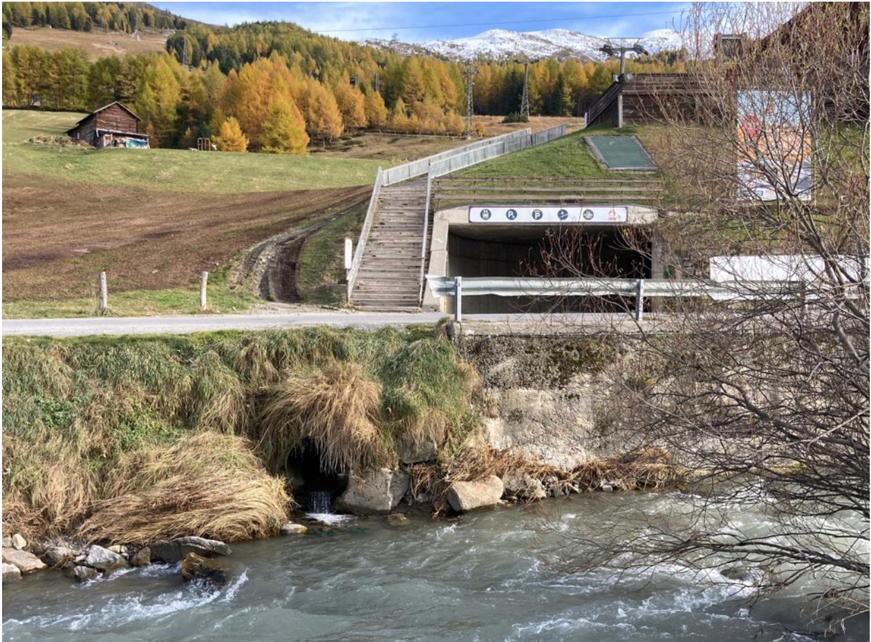
Figura 3.1: Sbocco del Rin dal Domenin nel T. Spöl tramite tubazione in cls
