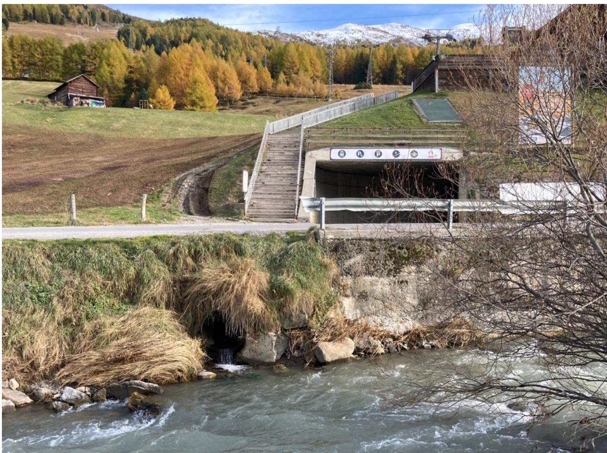
*Figura 2-1: Sbocco del Rin dal Domenin nel T. Spöl tramite tubazione in cls*
