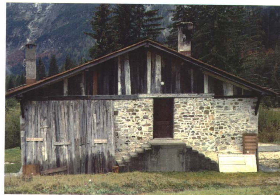
Prospetto fronte a monte
