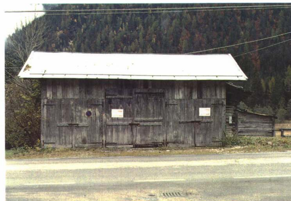
Prospetto fronte a monte
