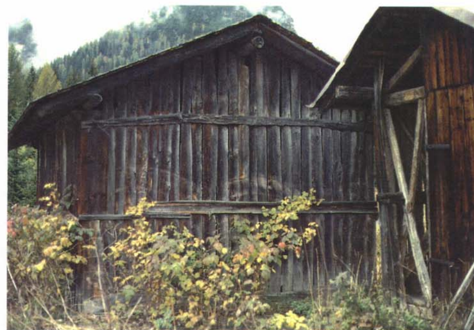
Prospetto fronte a monte
