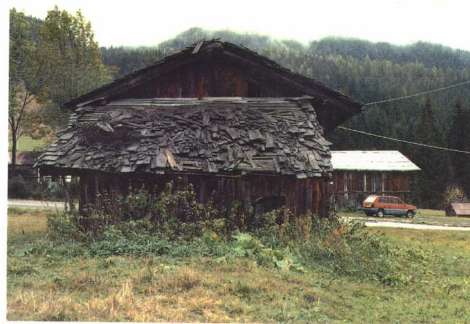
Prospetto fronte a monte
