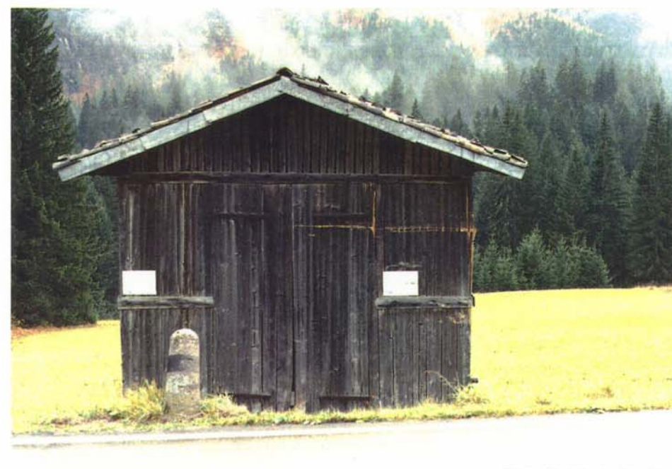
Prospetto fronte a monte
