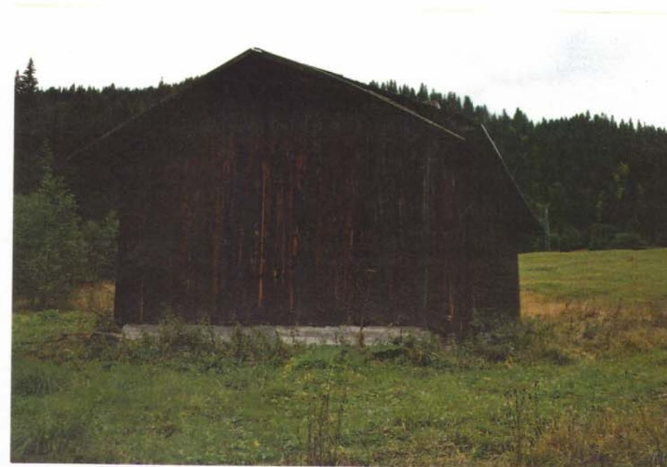
Prospetto fronte a monte
