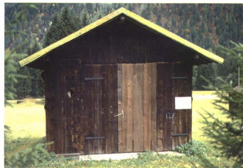
Prospetto fronte a monte
