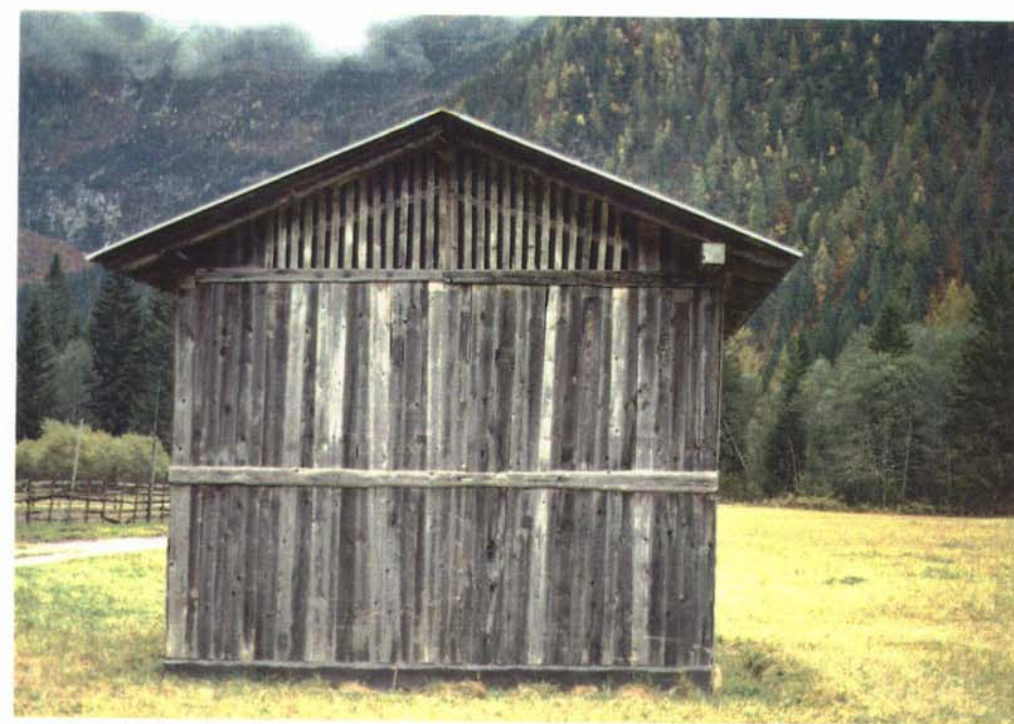
Prospetto fronte a monte
