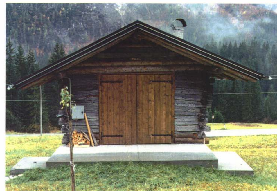
Prospetto fronte a monte
