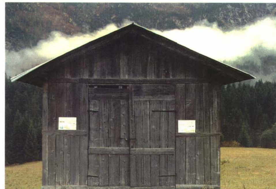
Prospetto fronte a monte
