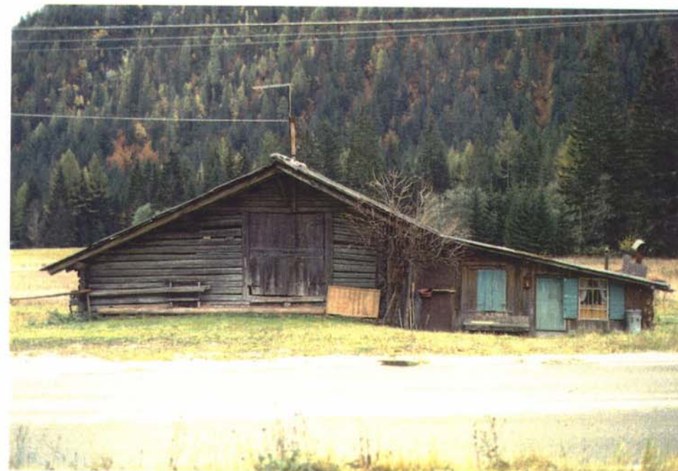
Prospetto fronte a monte
