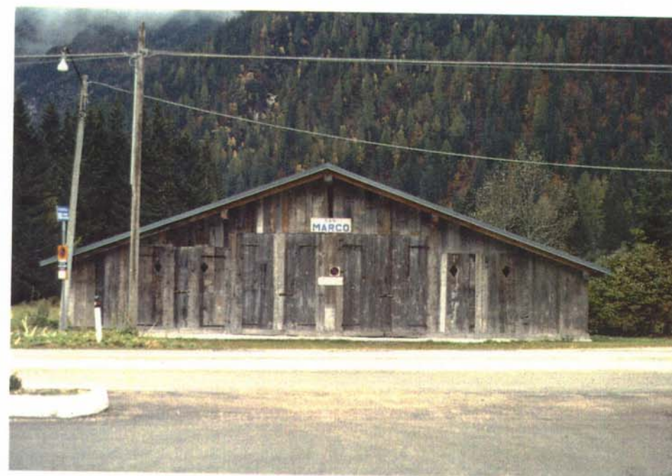
Prospetto fronte a monte
