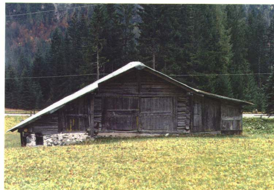
Prospetto fronte a monte
