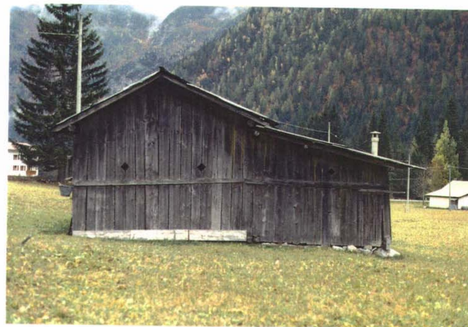
Prospetto fronte a monte
