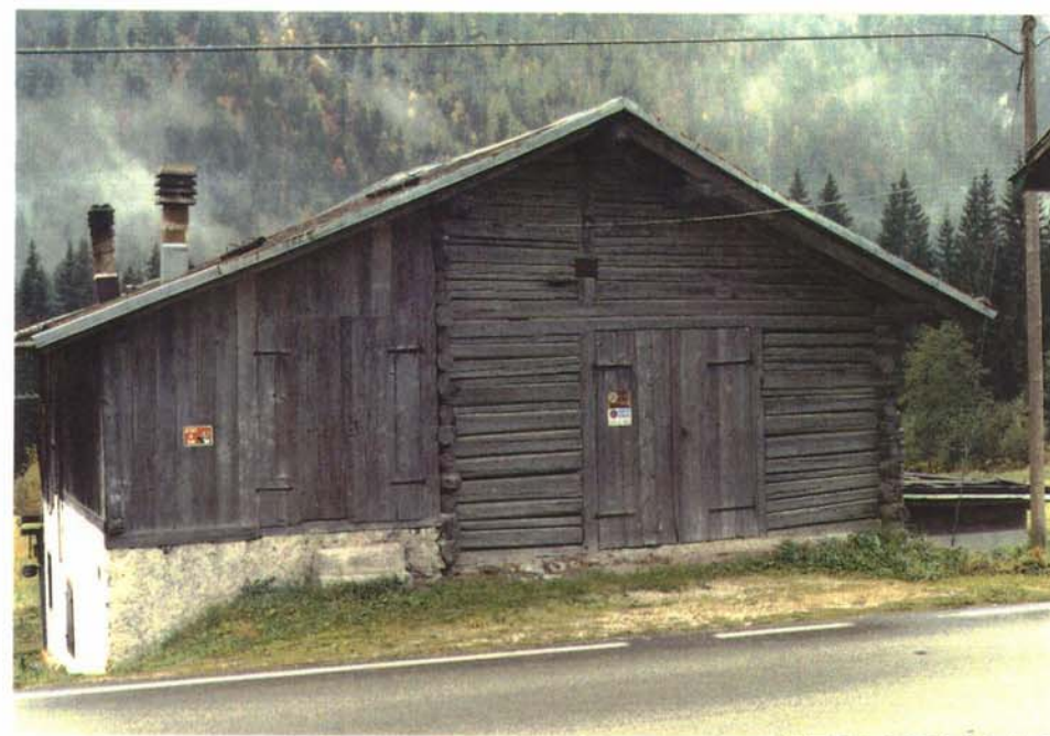
Prospetto fronte a monte
