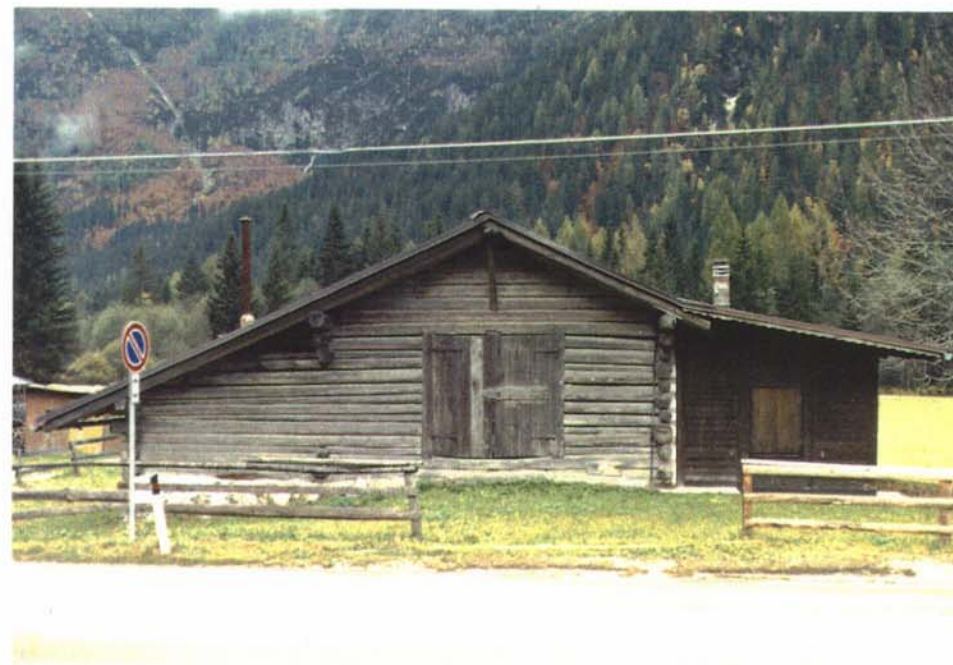
Prospetto fronte a monte
