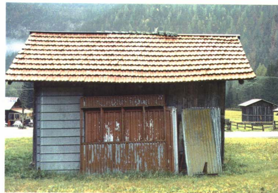
Prospetto fronte a monte
