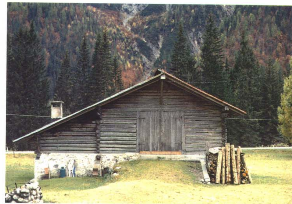
Prospetto fronte a monte
