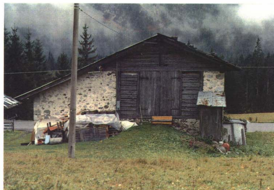
Prospetto fronte a monte
