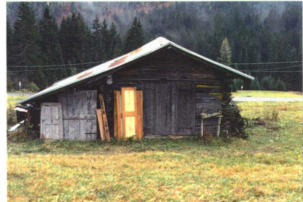
Prospetto fronte a monte
