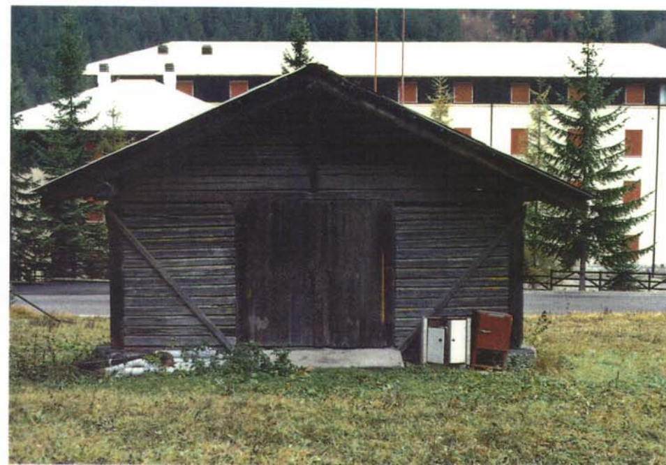
Prospetto fronte a monte
