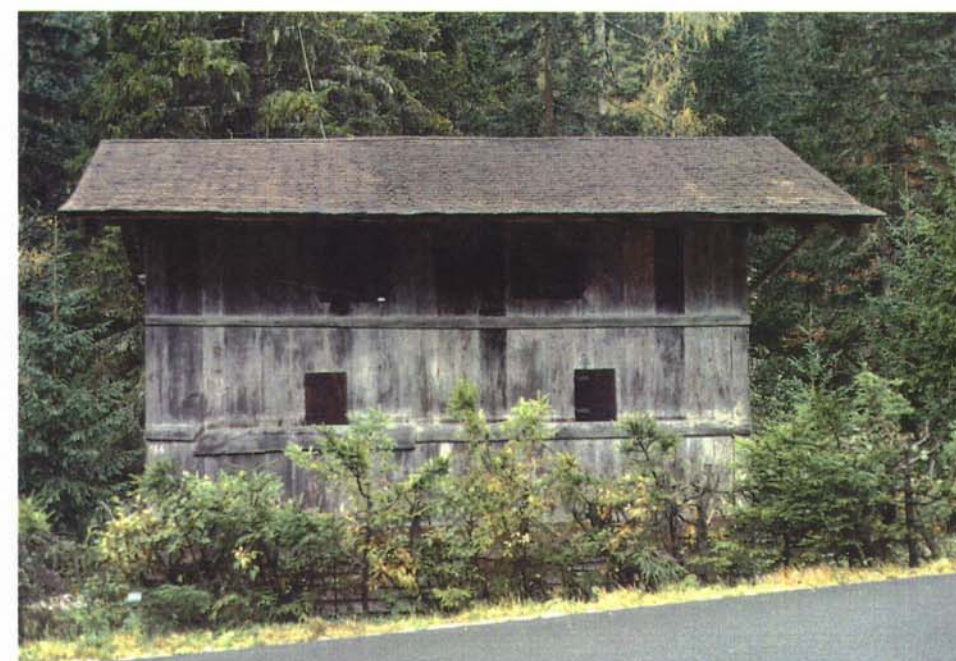
Prospetto fronte a monte
