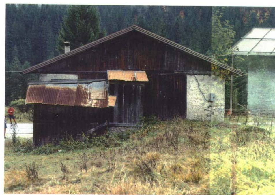
Prospetto fronte a monte
