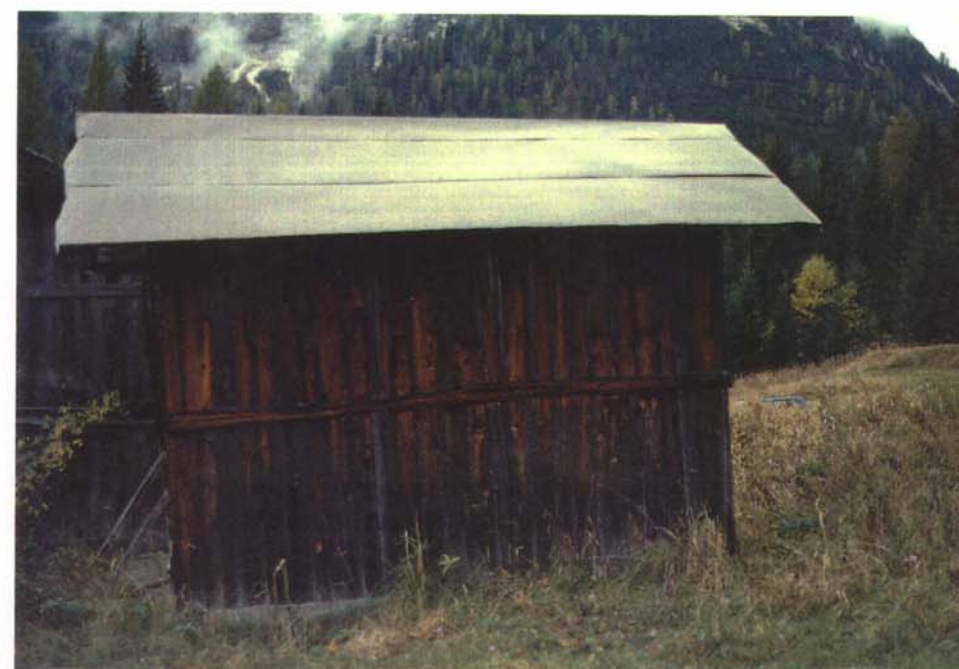
Prospetto fronte a monte
