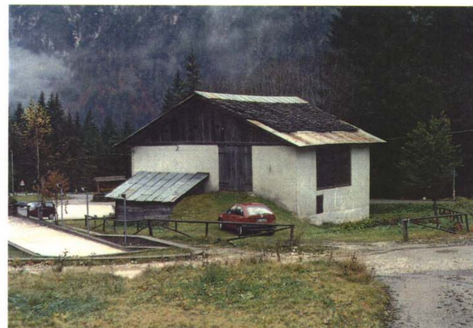
Prospetto fronte a monte
