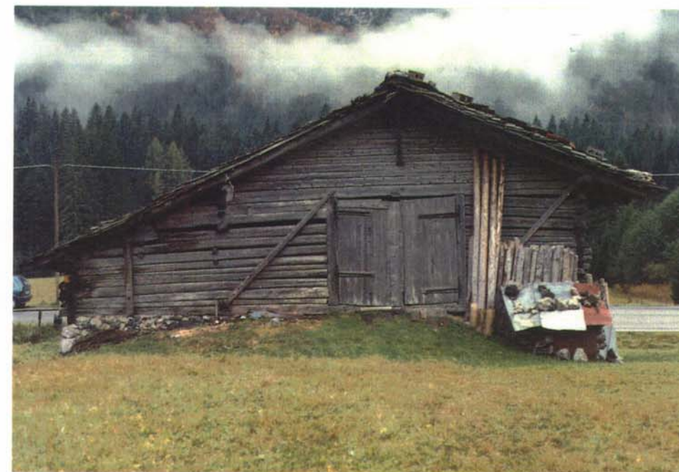
Prospetto fronte a monte
