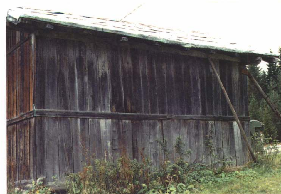
Prospetto fronte a monte
