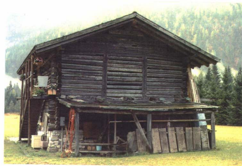
Prospetto fronte a monte
