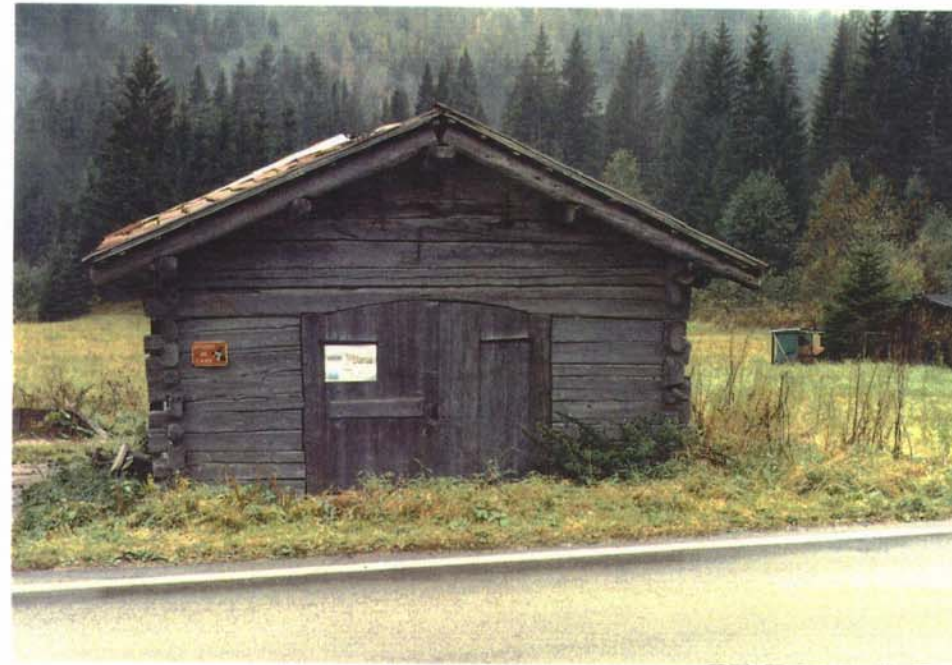
Prospetto fronte a monte
