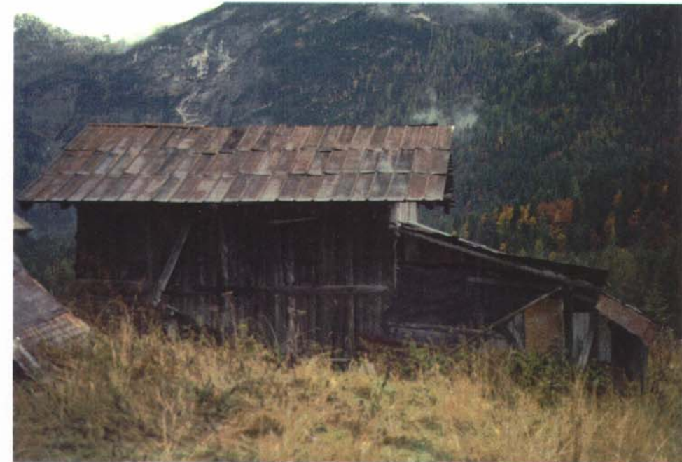
Prospetto fronte a monte
