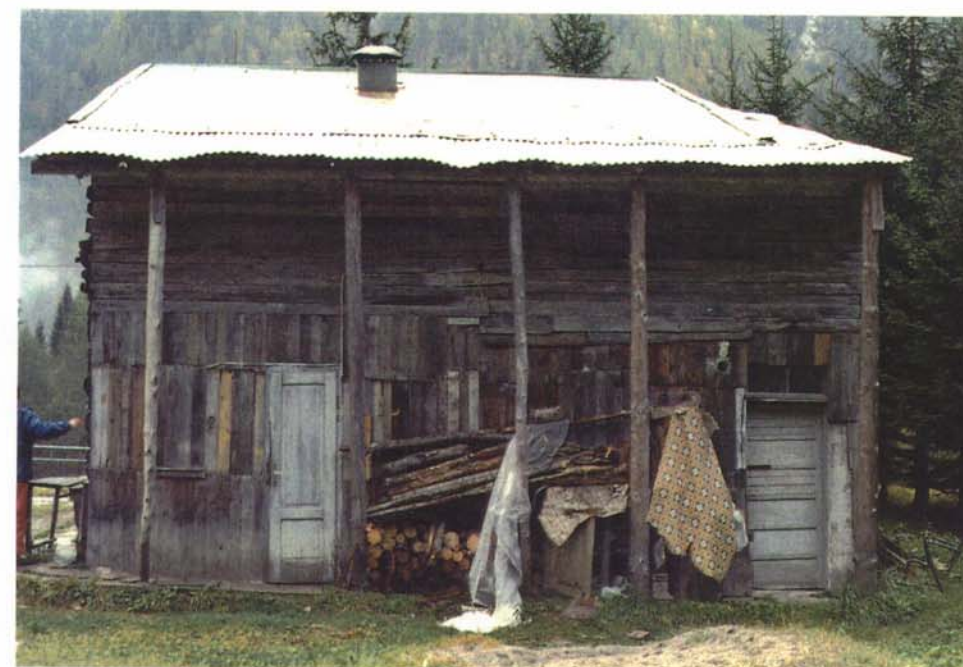
Prospetto fronte a monte
