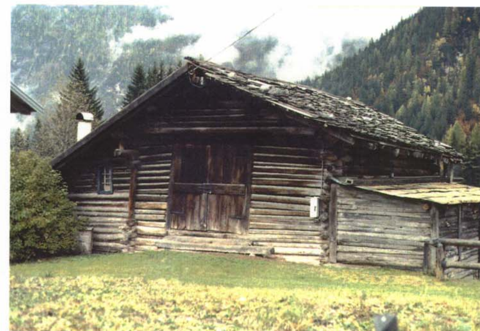
Prospetto fronte a monte
