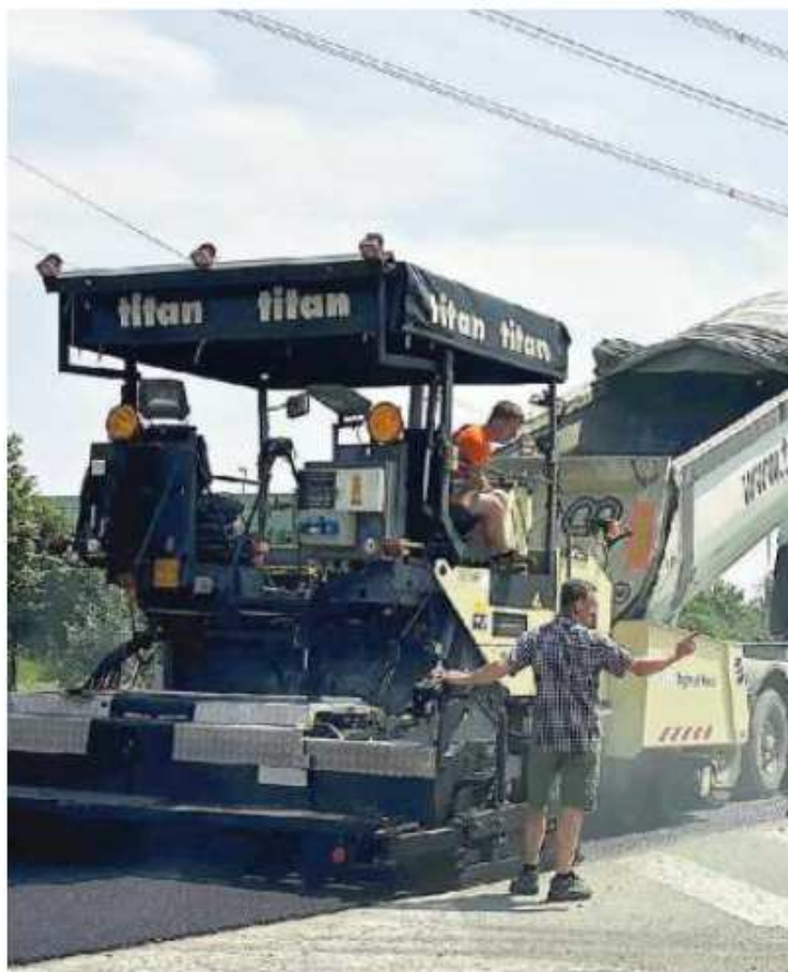
Lavori in corso per il rifacimento delle strade a Mirano
