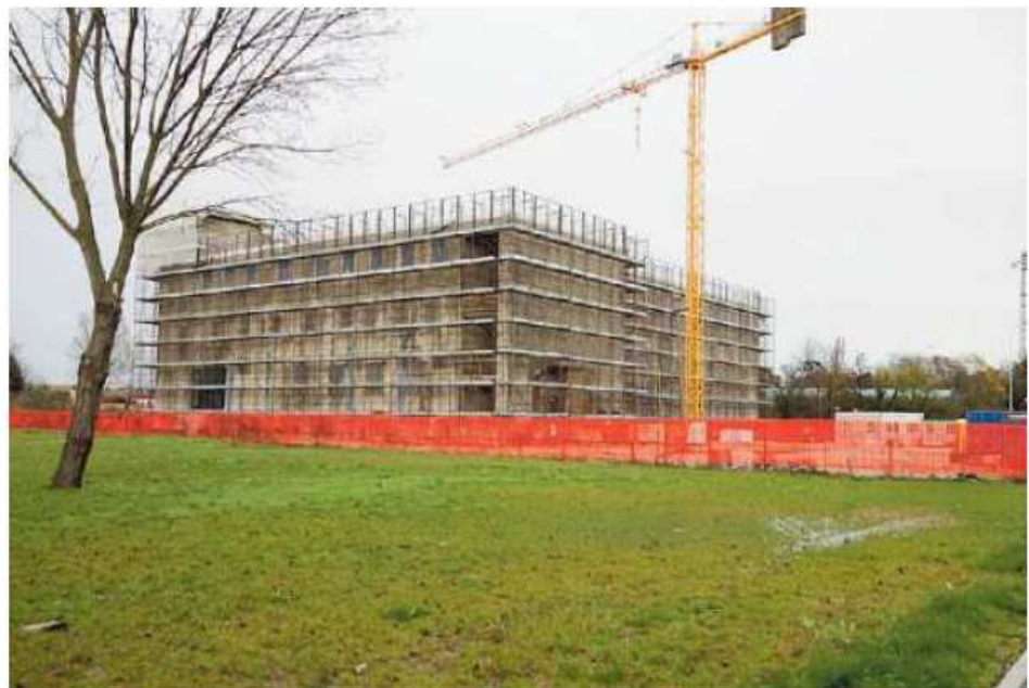
Il cantiere della nuova clinica del Centro di Medicina
