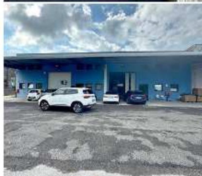
In alto il lucernario sfondato, sotto, la Standhouse di Santa Maria di Sala e i sigilli dell'Usl 3
