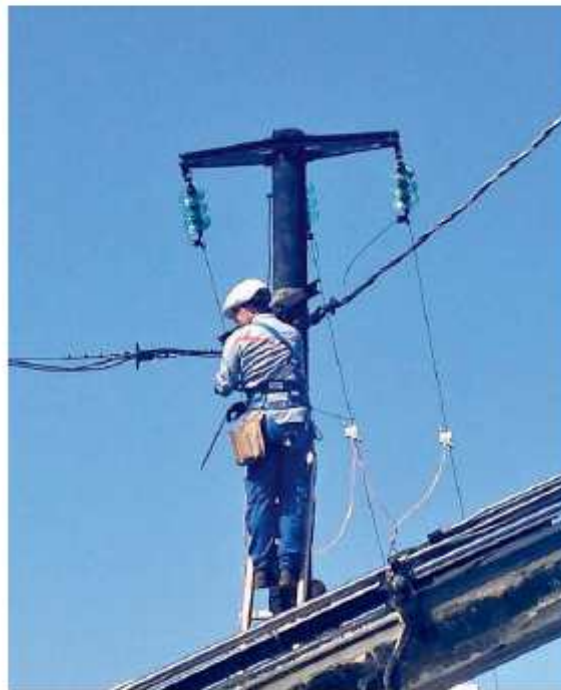
Un tecnico Enel al lavoro
