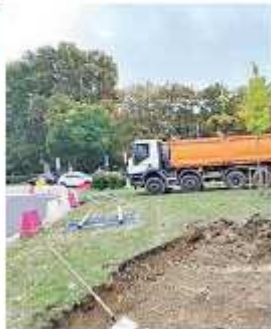
L'avvio del cantiere
