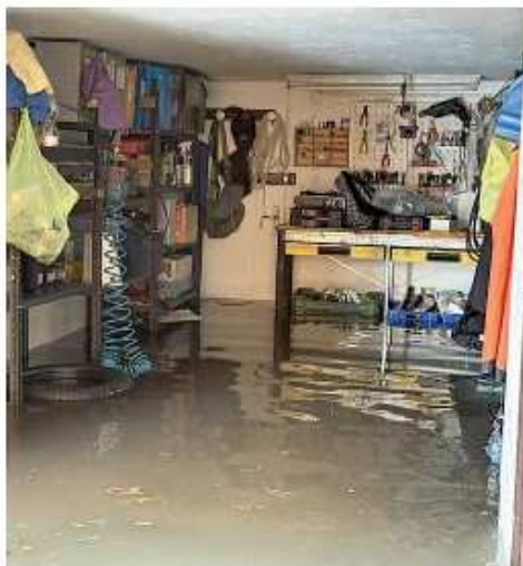
I DANNI PER MILIONI DI EURO UN GARAGE ALLAGATO ALLA BISSUOLA A DESTRA, FABRIZIO ZABEO
