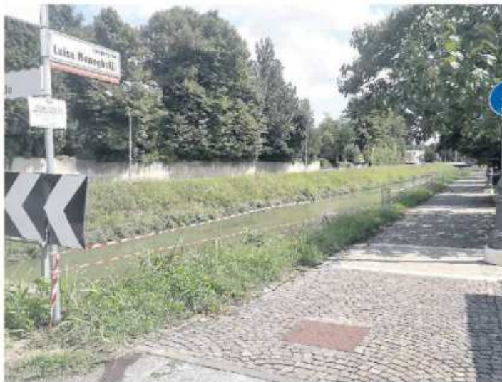
MIRANO Argini e terrapieni sotto osservazione per il rischio di cedimenti
