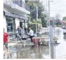
L'ONDATA DI AGOSTO I danni in una via di Mirano dopo la pioggia dello scorso agosto
