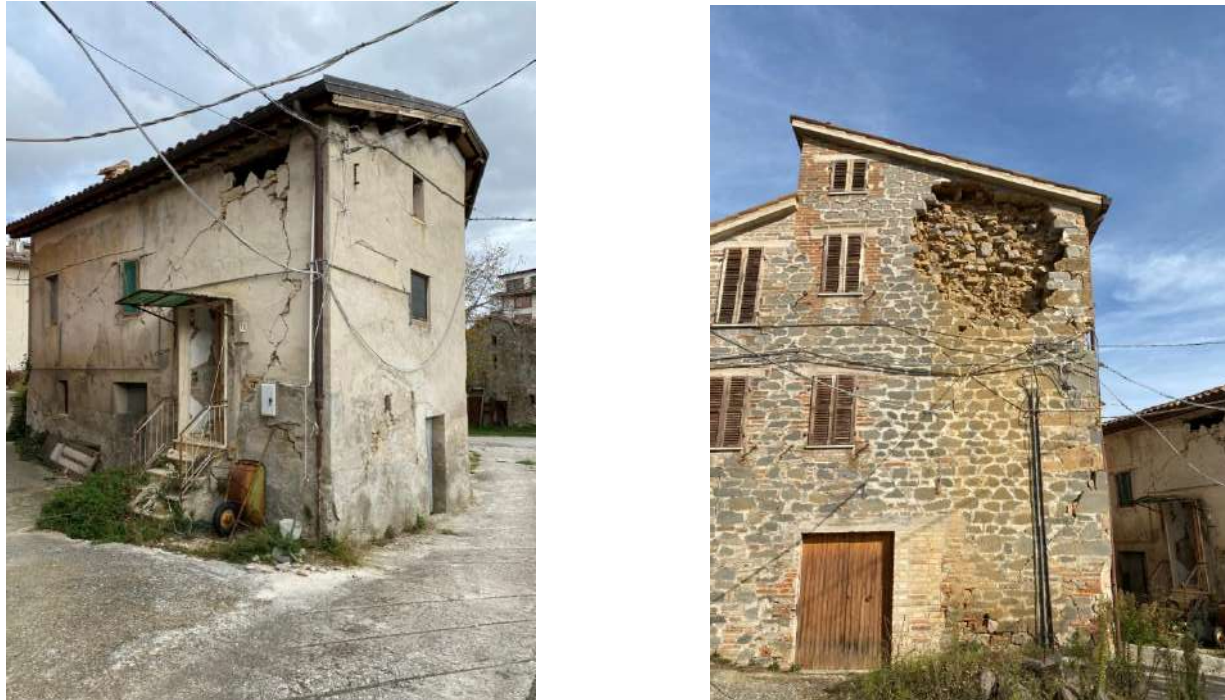
Figura 11 Cese, edifici danneggiati dalla sequenza sismica 24/08/2016 e seguenti
