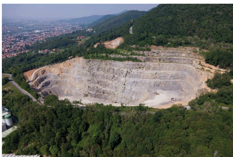
Figura 1.52 – Cava dei Cugini ripresa dall'alto. Si notano gli evidenti gradoni che caratterizzano il sito di estrazione. La progettazione dell'altezza di ogni elemento deve essere molto accorta: un errore in fase di progettazione può comportare una prematura chiusura del sito di coltivazione a causa dell'impossibilità di continuare gli scavi. Fotografia di Cugini SpA.
