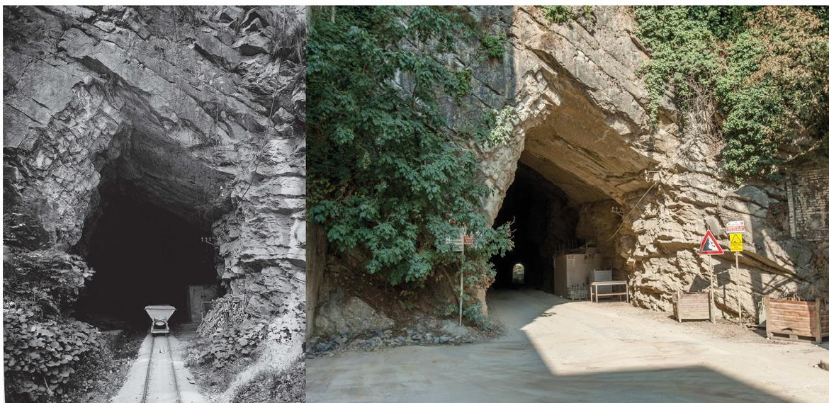
Figura 1.49 – Immagini della galleria che congiunge il sito di estrazione con l'impianto di lavorazione. A sinistra una foto storica, in cui si nota da décauville e un carrello di trasporto. A destra la galleria oggi, con l'entrata ampliata per il passaggio degli automezzi. Fotografie di Cugini SpA.
