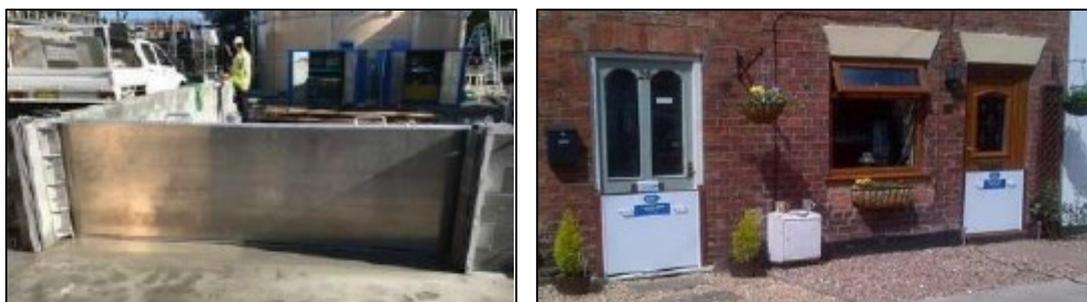
A sinistra: paratoia di chiusura a scorrimento orizzontale per un cancello a tenuta idraulica, a destra: paratoie manuali a protezione di porte di ingresso.
